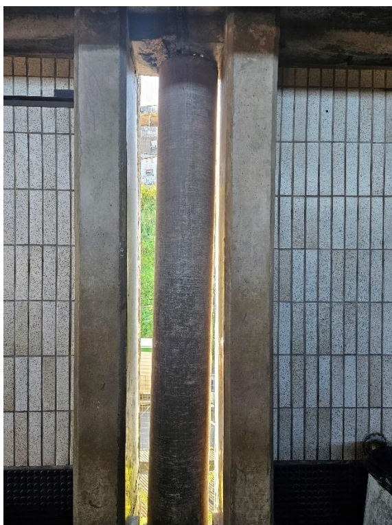
Foto 2-146: Pilar Torto, ferragem exposta e infiltração na viga
