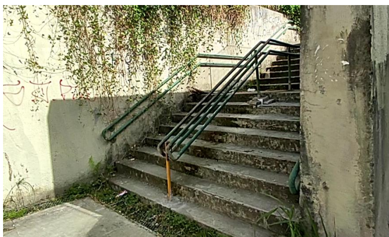
Foto 2-231: Escada de Acesso a Estação sem elementos de acessibilidade, pisos e grelhas degradados
