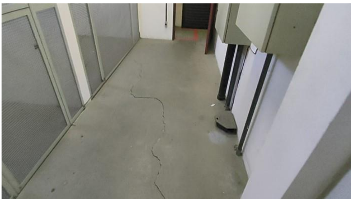
Foto 3-61: Fissura no piso da Subestação Auxiliar
