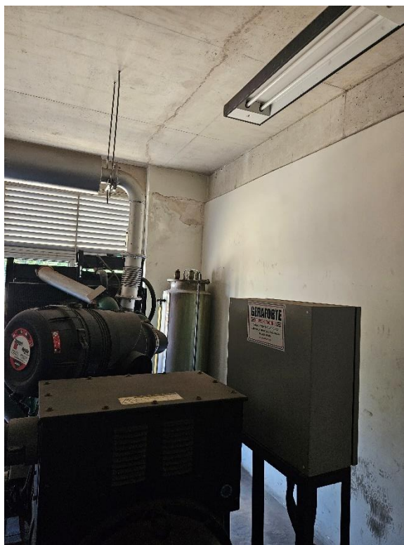
Foto 2-12: Salas Técnicas – Infiltrações, Revestimentos danificados, Rachaduras
