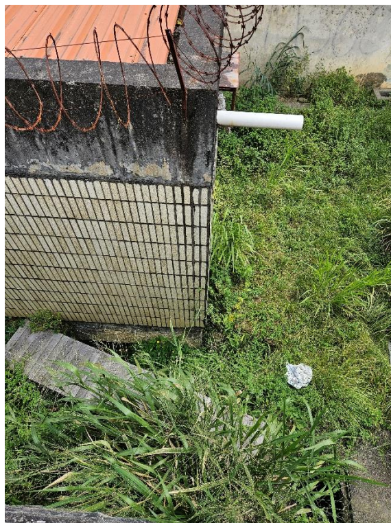
Foto 2-136: Problemas estruturais – perda de solo sob o edifício operacional, murro de arrumo com rachaduras
