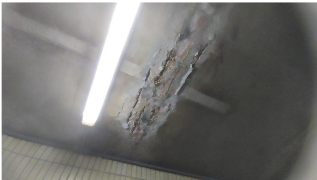
Foto 2-186: Infiltração e ferragem exposta em laje
