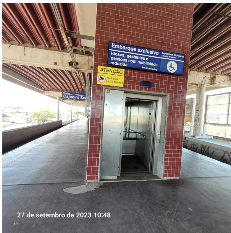
Foto 3-152: Piso da plataforma remendado próximo à entrada do elevador
