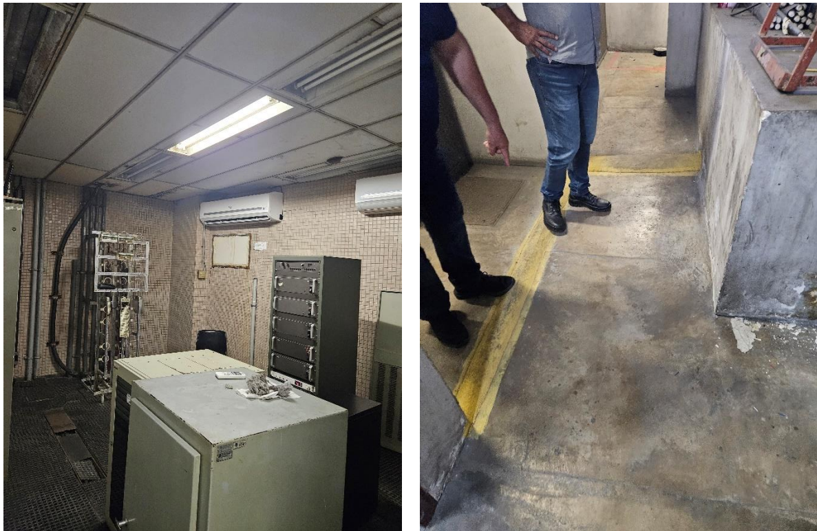
Foto 2-44: Salas Técnicas – Piso e Forro degradados, contruídas barreiras para impedir entrada de água
