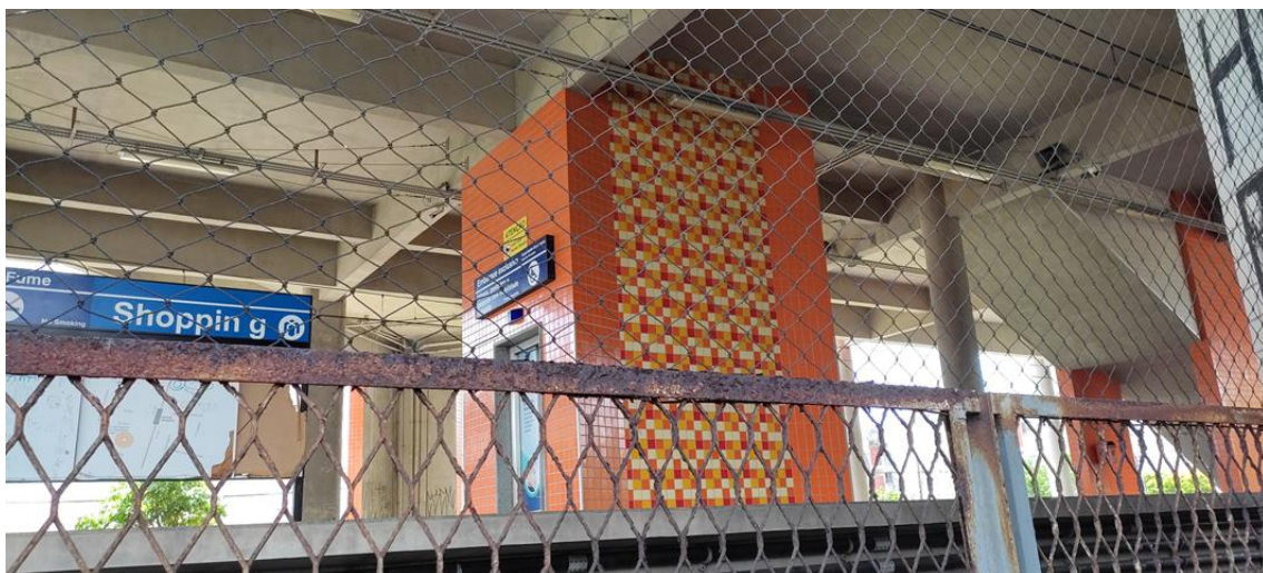
Foto 3-86: Gradis de proteção à área da plataforma apresentando elevado grau de oxidação
