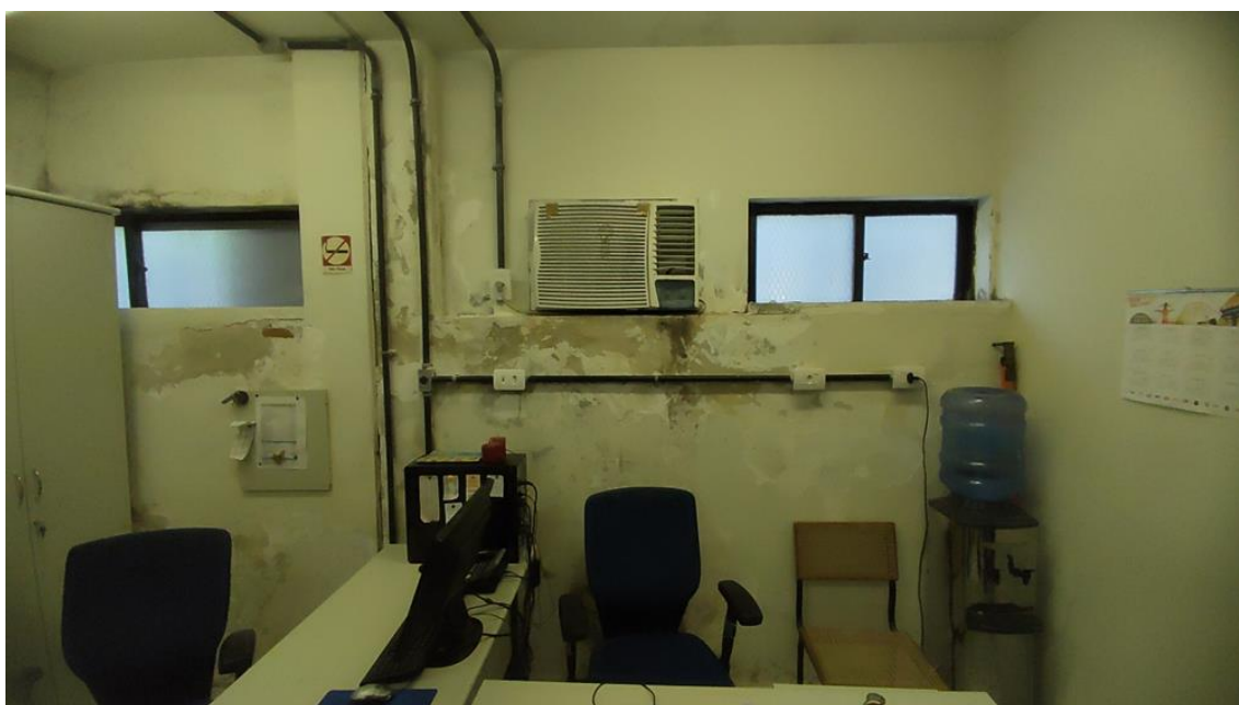
Foto 3-138: Parede desgastada por infiltração em sala técnica
