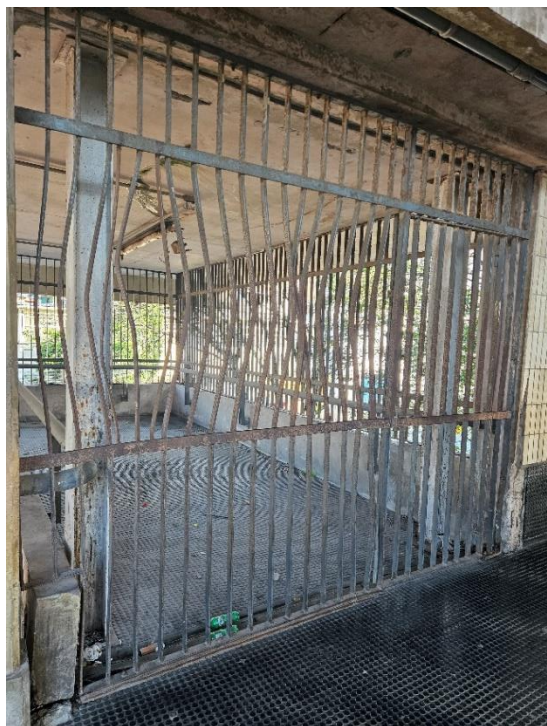
Foto 2-147: Acesso Bloqueado – Portões tortos devido a sobrecarga. A direita rampa (atualmente fechada) com reforço no engaste com o edifício da estação
