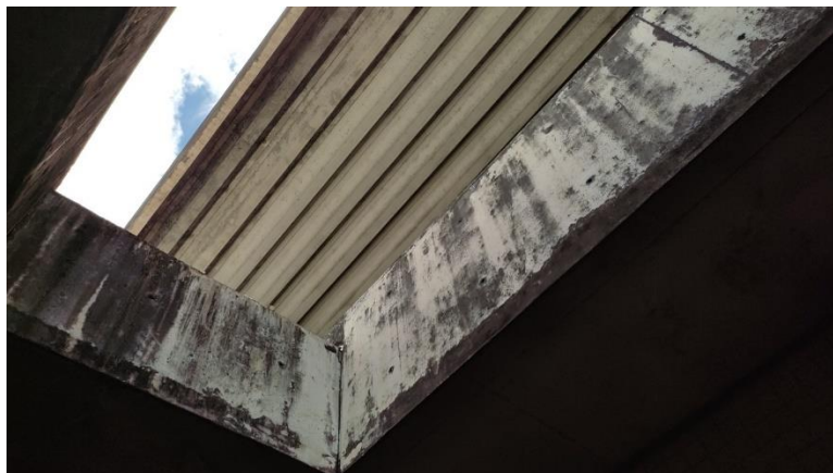
Foto 2-252: Necessidade de manutenção em telhas e tratamento e limpeza do concreto aparente
