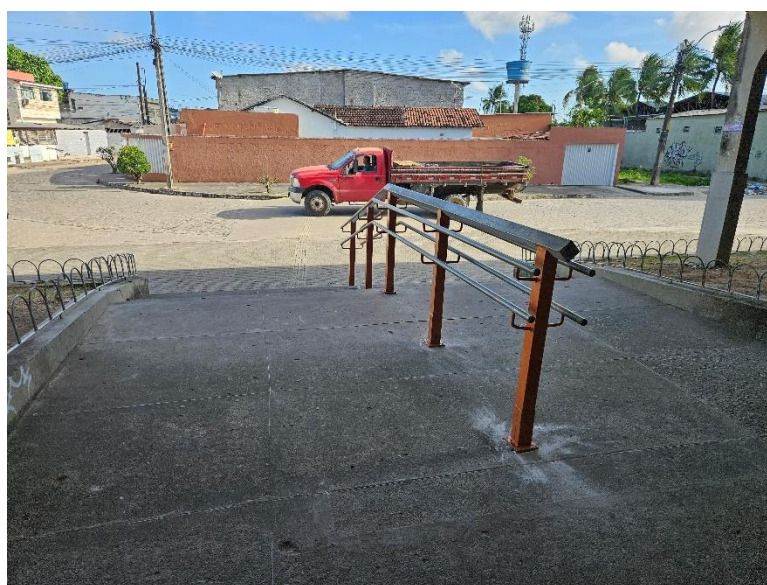
Foto 2-68: Escada sem Guarda Corpo e elementos normativos, Travessia Inadequada
