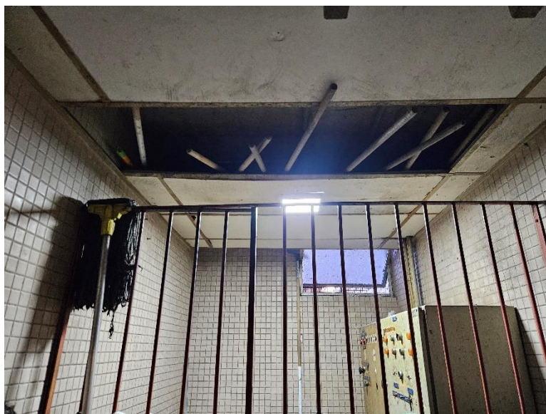
Foto 2-98: Salas Operacionais – Forros, Revestimento Cerâmico e Pisos degradados
