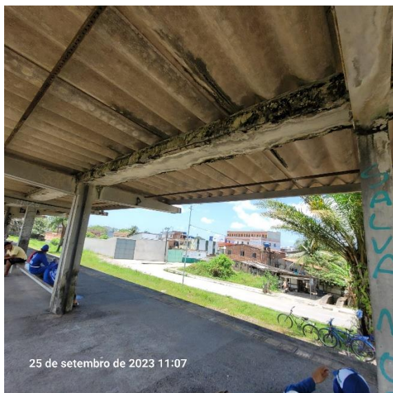
Foto 4-26: Telhado com infiltrações e viga apresentando deslocamento
