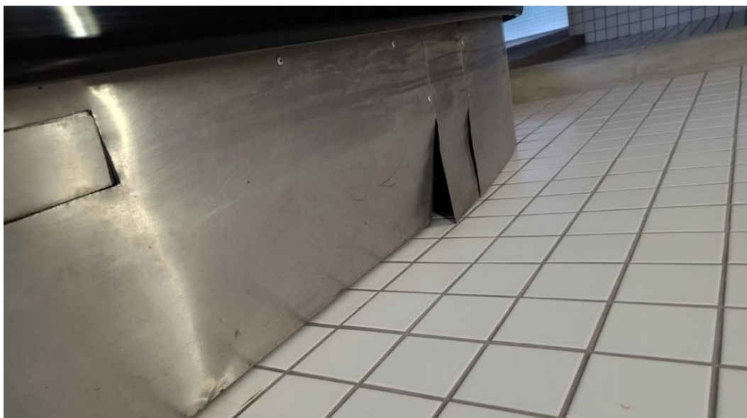
Foto 5-3: Escada rolante com a estrutura lateral danificada – Estação Cosme e Damião
