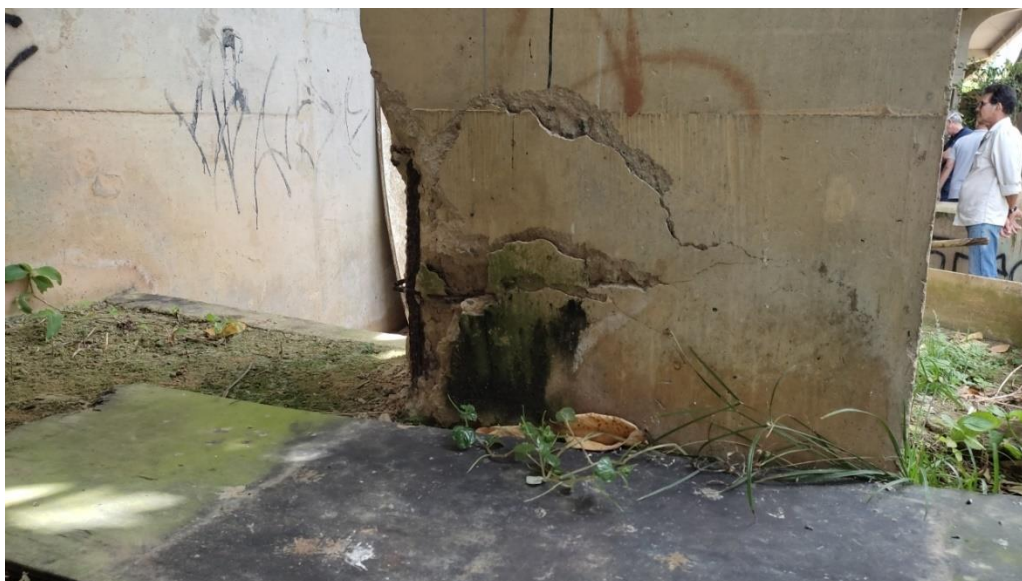
Foto 2-175: Pilar de sustentação da Rampa coprometido
