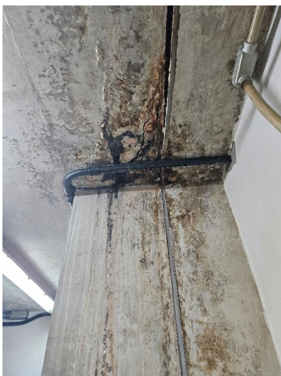
Foto 2-152: Salas Operacionais e Técnicas – Infiltrações, acabamentos degradados e instalações improvisadas.
