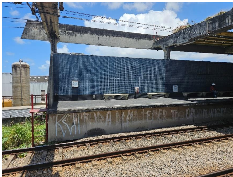
Foto 2-37: Plataforma – Ausência de cobertura, pichações, infiltrações
