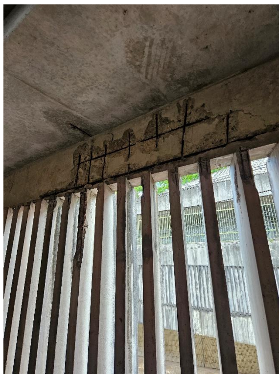
Foto 2-130: Ferragens expostas em viga e em brises de fechamento e Infiltração
