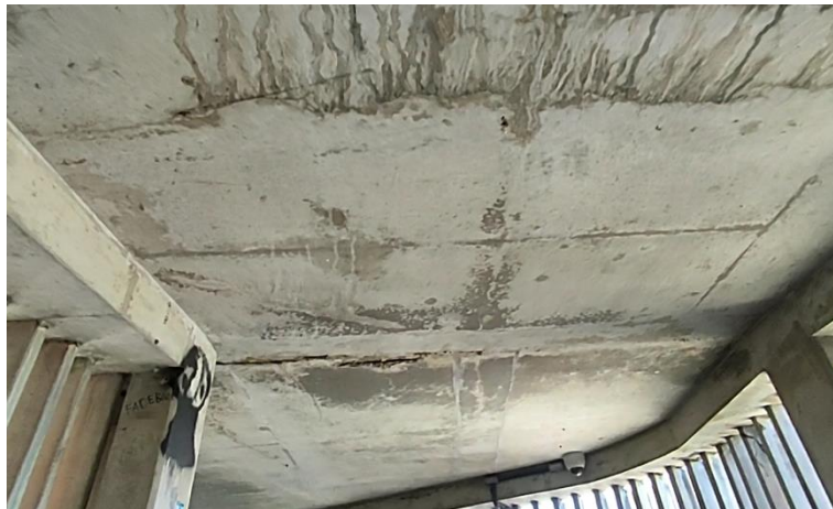
Foto 2-30: Rampa de Acesso a Plataforma - Ferragem exposta e revestimento cerâmico danificado
