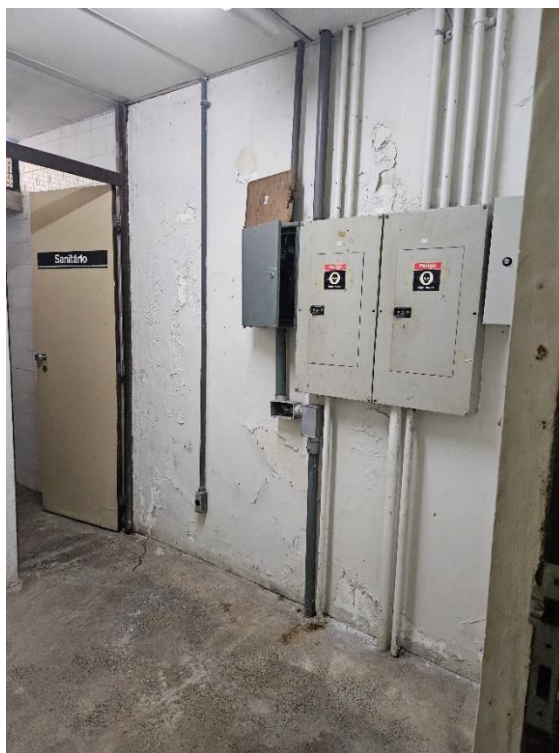
Foto 2-222: Área inoperante, possui infraestrutura elétrica, hidráulica. Revestimentos degradados e infiltrações.
