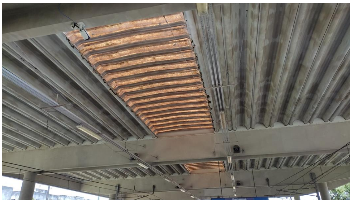
Foto 3-85: Telhas e domos da cobertura da plataforma comprometidos. Oxidação aparente devido à infiltração
