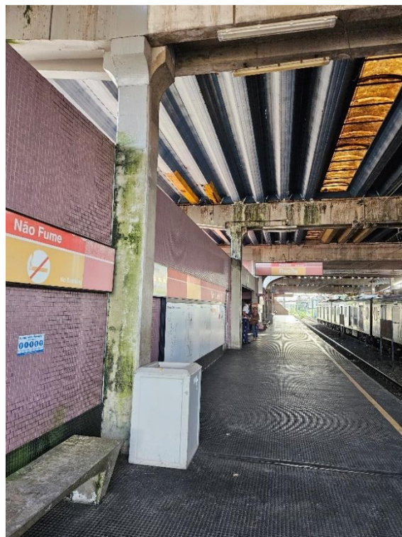
Foto 2-80: Infiltrações, trincas e bicheiras nos Pilares, Vigas e Paredes. Ausência de Rota Tátil.
