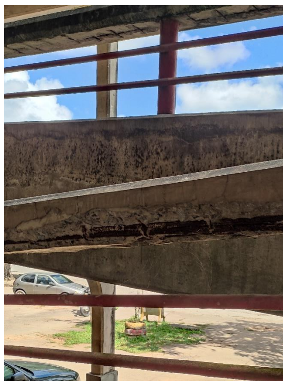
Foto 2-160: Rampas – Infiltrações, bicheiras, ferragens expostas
