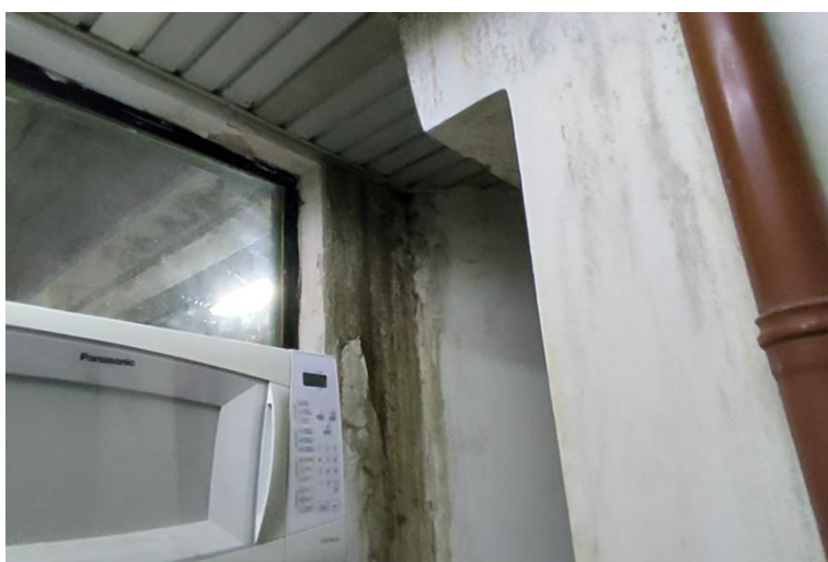
Foto 2-28: Salas Operacionais – Infiltrações e Forro degradado
