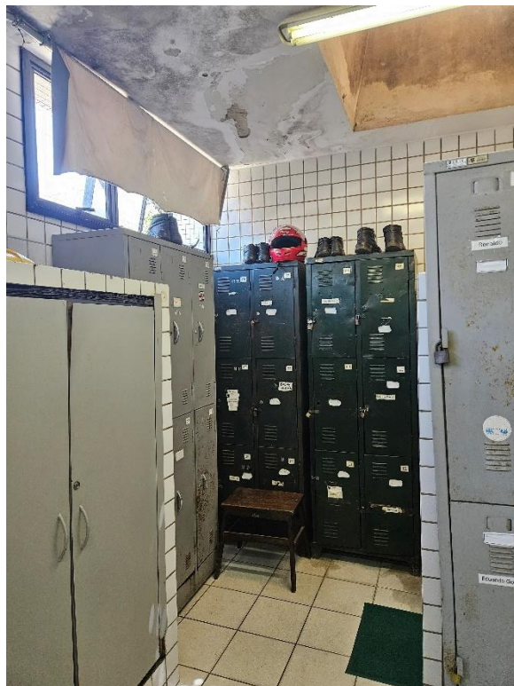
Foto 2-11: Sanitário e Vestiário Operacional – Infiltrações, Revestimentos danificados, Ausência de Elementos
