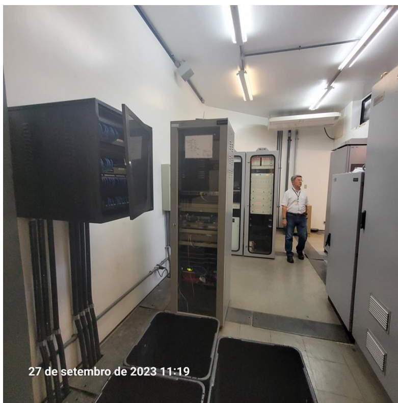
Foto 3-159: Sala de Telecomunicações com baldes para contenção da água da chuva provinda da via permanente
