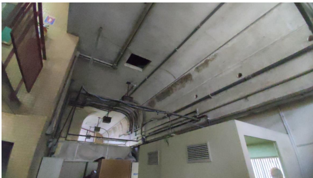
Foto 2-173: Infiltrações e fiações elétricas improvisadas
