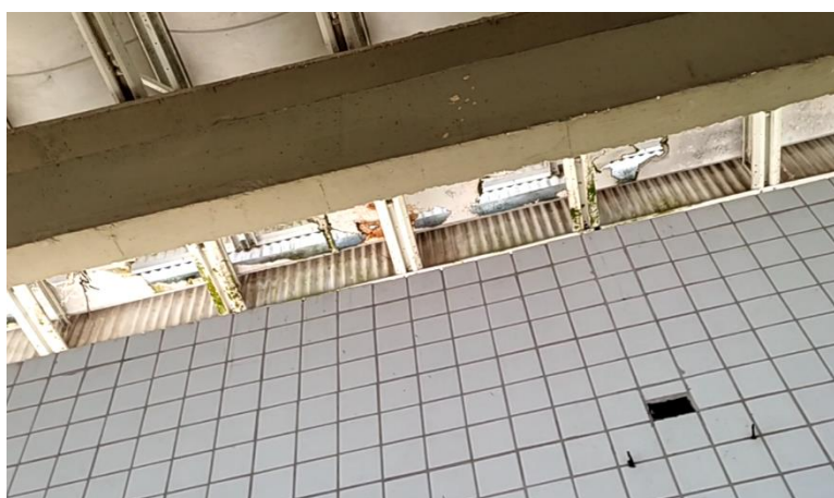
Foto 2-240: Cobertura – calha com corrosão e degradada
