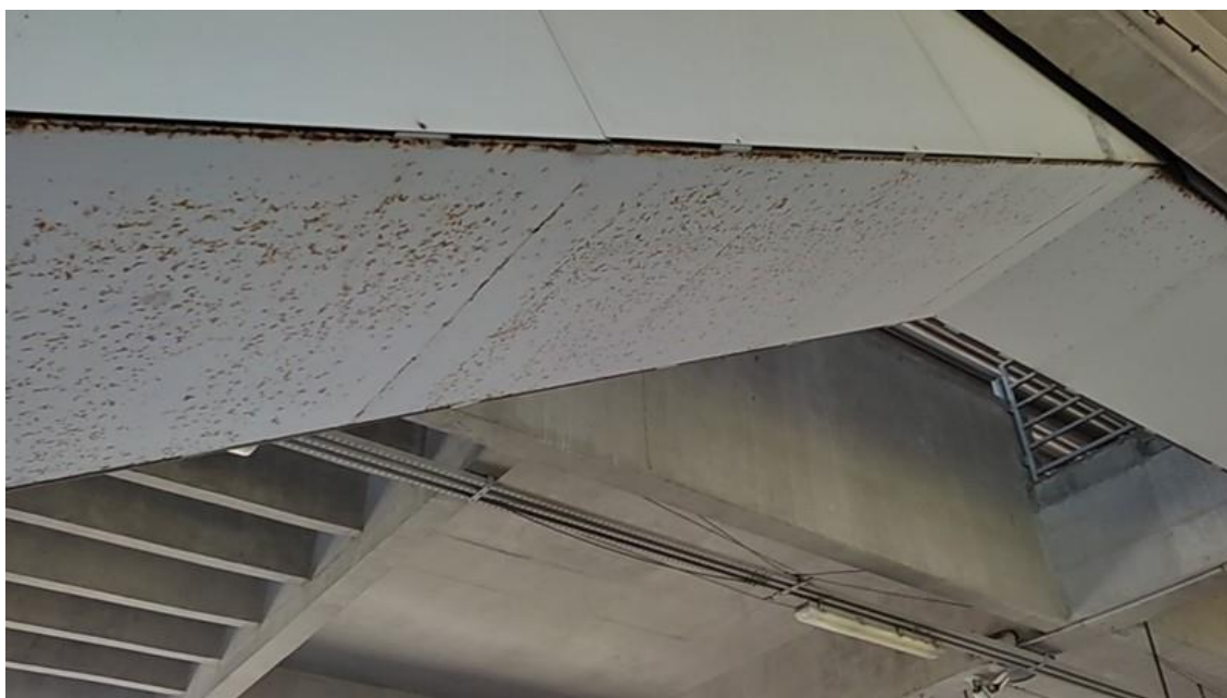
Foto 3-82: Escada rolante de acesso ao mezanino com oxidação na tampa de fundo
