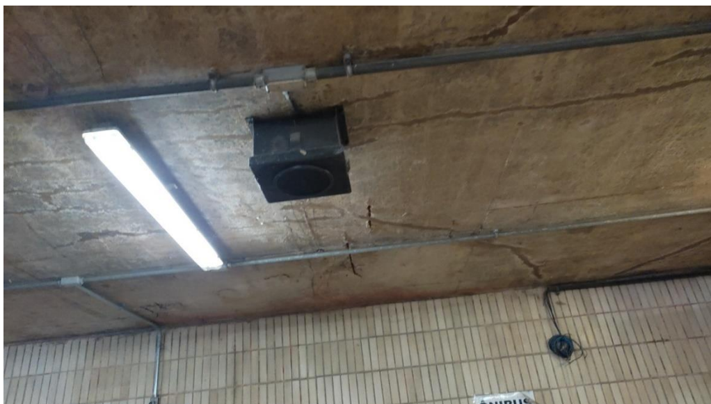
Foto 2-190: Saguão com infiltrações e ferragens expostas na laje
