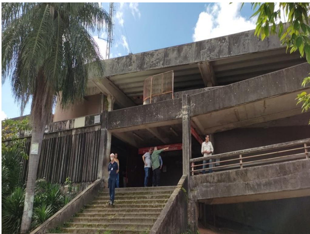
Foto 2-159: Rampa de Acesso a Passarela – Desnível do Lance maior que o permitido na Norma. Rampas e Escadas – ausência de elementos de acessibilidade
