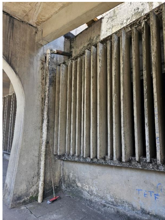
Foto 2-40: Rampas – Desnível por lance maior que permitido pela Norma. Infiltrações, bicheiras e ferragens expostas
