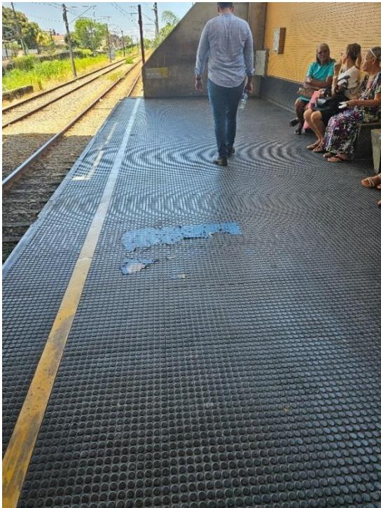
Foto 2-117: Plataformas – Sem rota tátil, sem elementos de acessibilidade, telhas e Domus danificados/faltantes, infiltrações nas vigas
