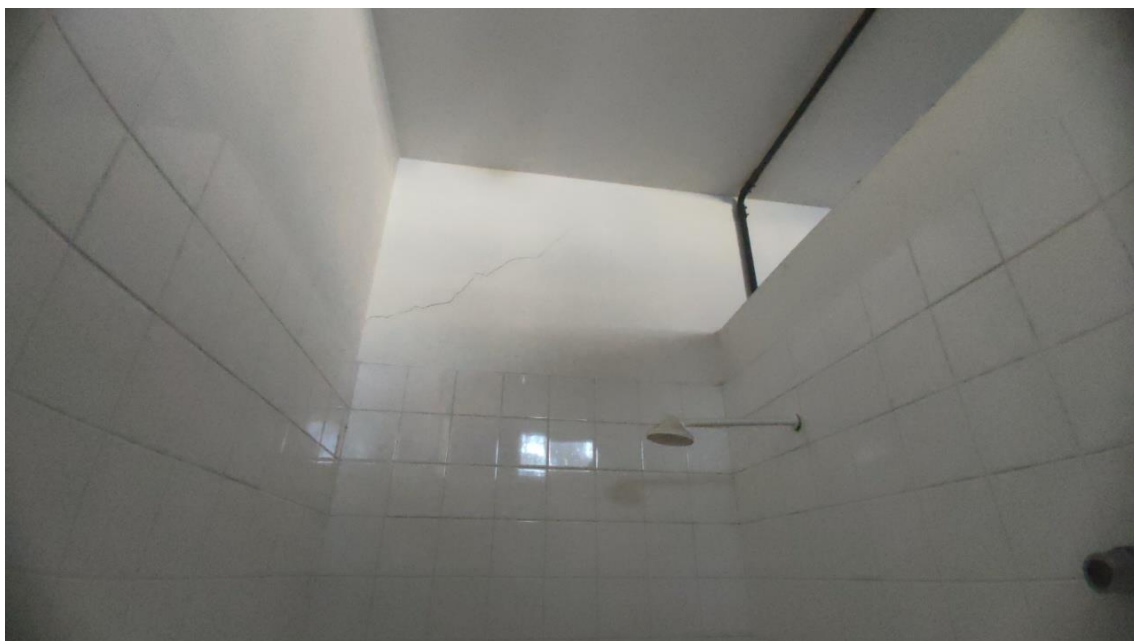
Foto 3-38: Parede de banheiro com fissuração aparente
