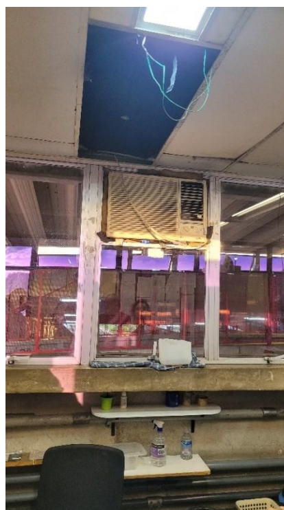
Foto 2-125: Instalações adaptadas nas salas administrativas, forros e revestimentos degradados
