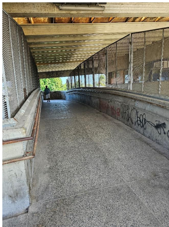
Foto 2-67: Rampa sem elementos da Norma, desnível por lance maior que o permitido. Gradis degradados
