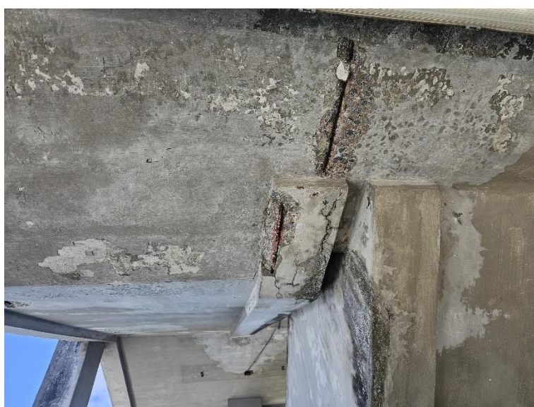
Foto 2-14: Passarela Área Operacional – Infiltrações, Rachaduras, Ferragens Expostas, Bicheiras
