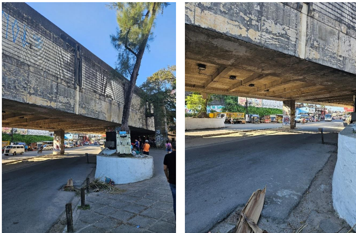
Foto 2-149: Necessidade de limpeza e tratamento do concreto aparente, pintura e tratamento das infiltrações
