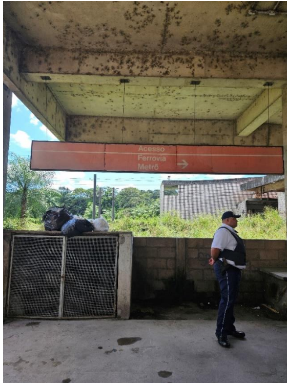
Foto 2-217: Infiltrações na Laje. Área de armazenamento de lixo pequena e com fechamento degradado. Rampa com desnível por lance maior que permitido por Norma, ferragens expostas, sem elementos de acessibilidade
