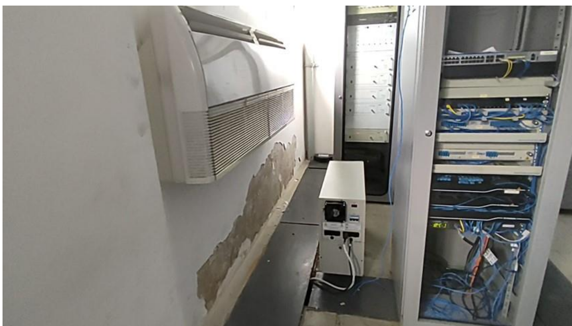
Foto 3-115: Parede descascada na Sala de Telecomunicações
