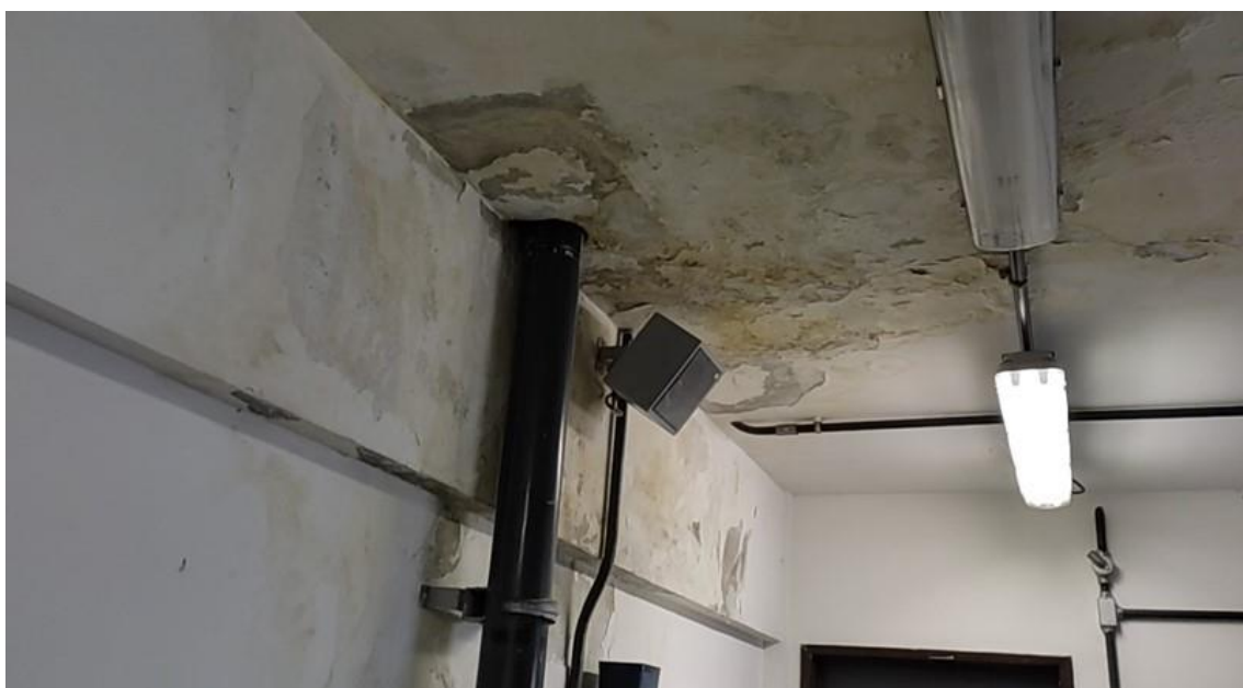
Foto 3-136: Laje e paredes da Sala de Telecomunicações intensamente degradadas devido à infiltração
