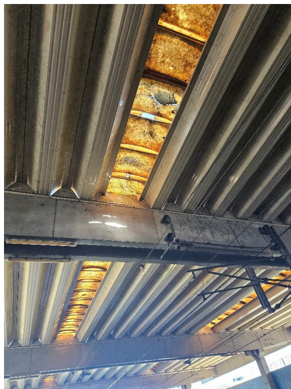
Foto 2-51: Cobertura da Plataforma – Domus e Telhas danificados
