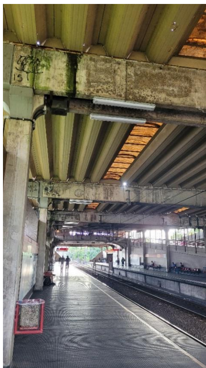
Foto 2-122: Plataformas – Ausência de Rota Tátil, infiltrações, telhas e Domus danificados
