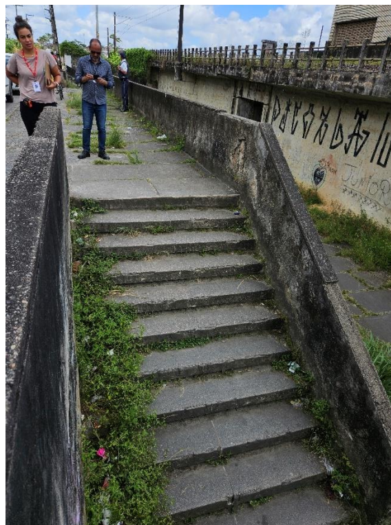
Foto 2-140: Rampa de Acesso a Passarela – Desnível do Lance maior que o permitido na Norma. Rampas e Escadas – ausência de elementos de acessibilidade
