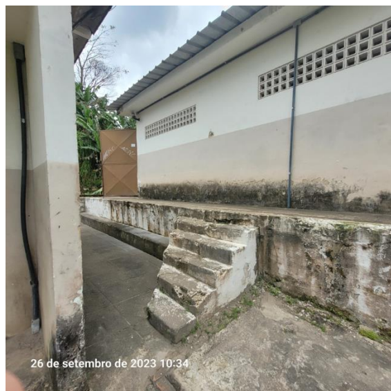
Foto 4-92: Falta de acessibilidade nas áreas operacionais da estação; concreto desgastado
