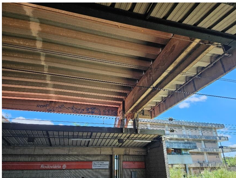
Foto 2-223: Infiltração, Lodo e Pichações nas vigas.
