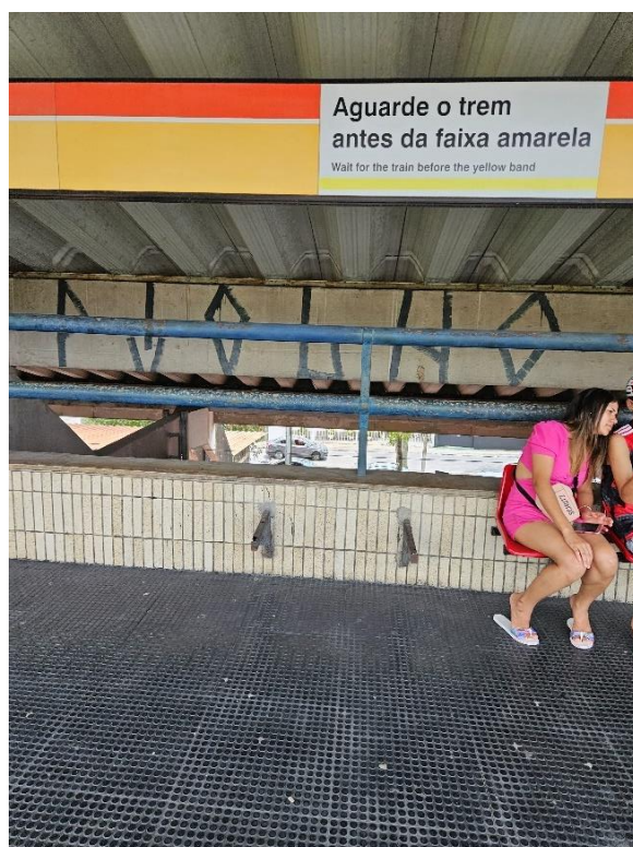
Foto 2-139: Plataformas 2Bis sentido Recife – vão 11cm maior que o permitido na Norma, bancos degradados
