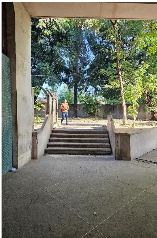
Foto 2-94: Escadas e Rampas de Acesso – Faltam elementos de acessibilidade
