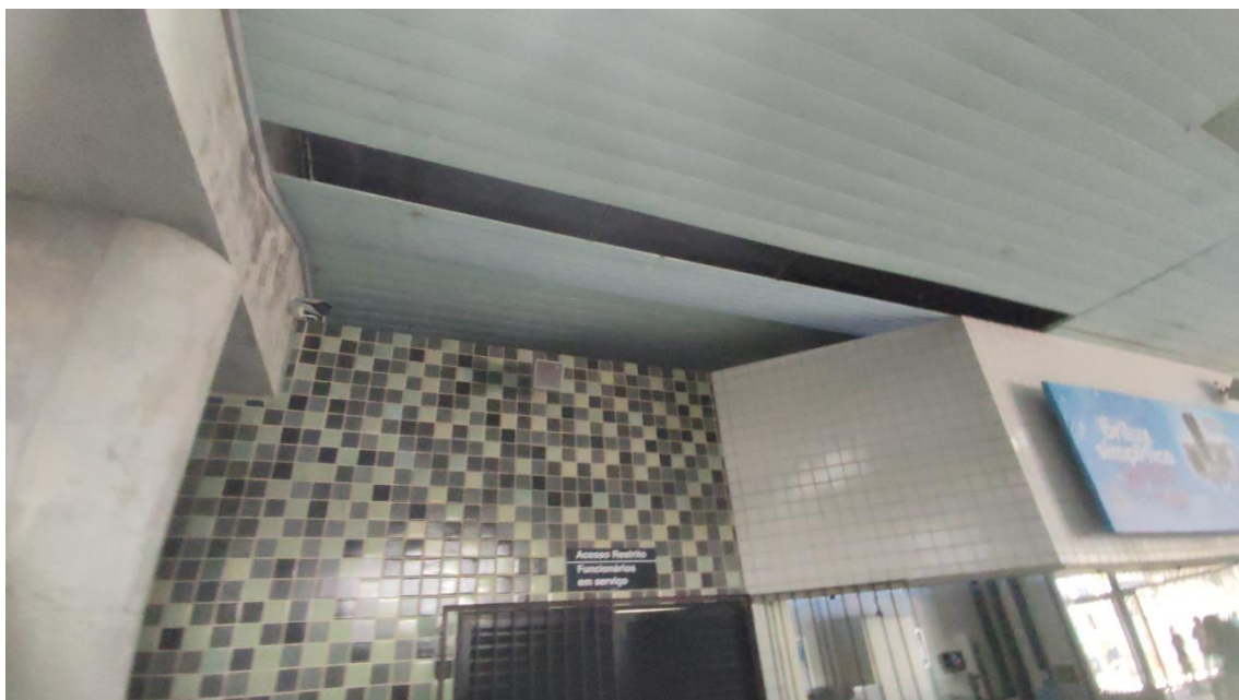
Foto 3-36: Forro em perfis metálicos, no saguão, com peça faltando
