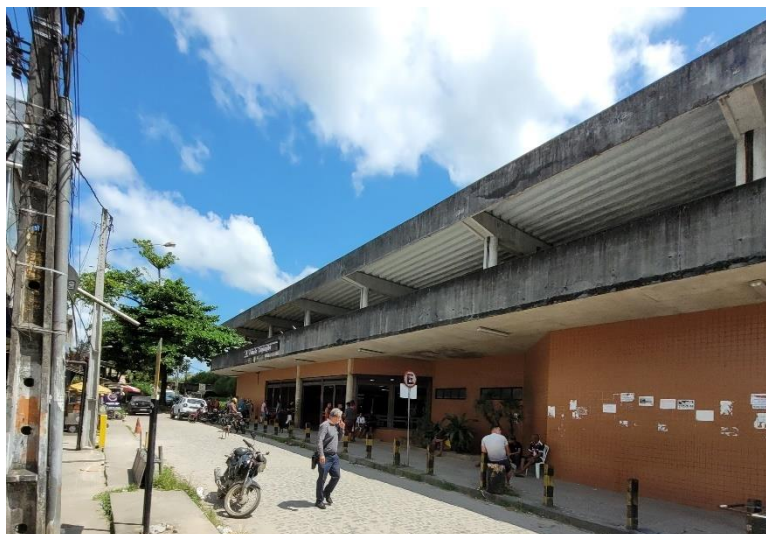
Foto 2-260: Necessidade de limpeza e tratamento do concreto aparente de toda a Estação. Limpeza da fachada de revestimento cerâmico e reposição de algumas peças
