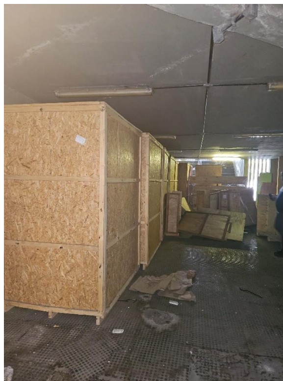
Foto 2-115: Área Disponível que atualmente é utilizada como depósito. Apresenta infiltrações e acabamentos danificados.
