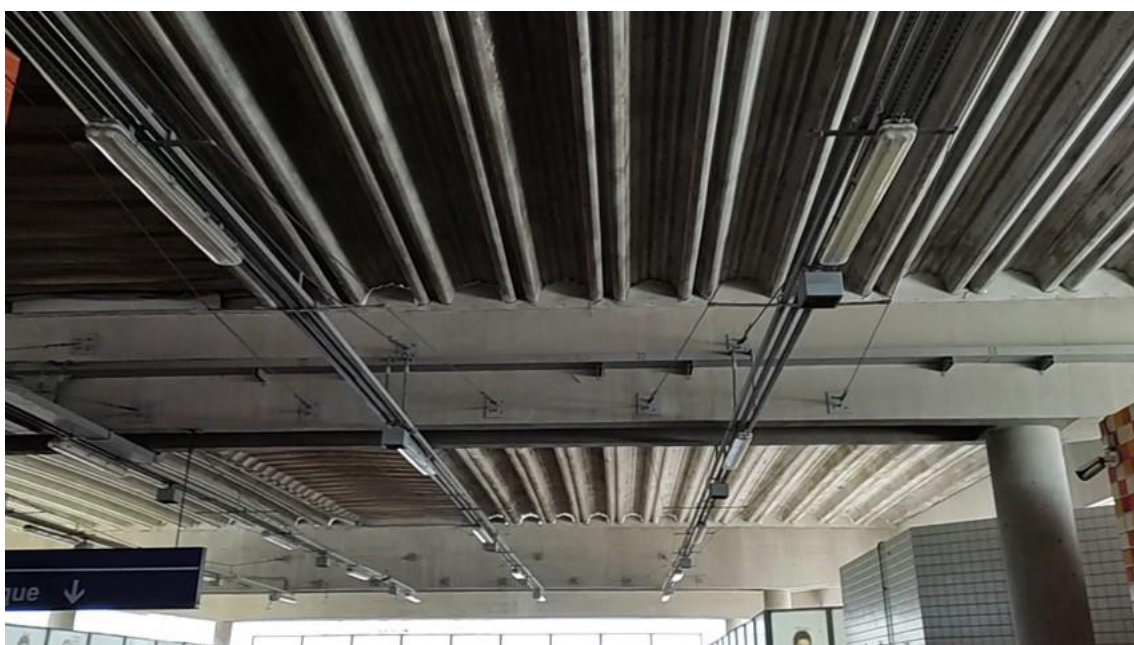
Foto 3-87: Telhas do saguão oxidadas
