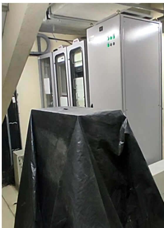
Foto 2-23: Salas Técnicas – Equipamentos cobertos devido a infiltrações, pisos danificados
