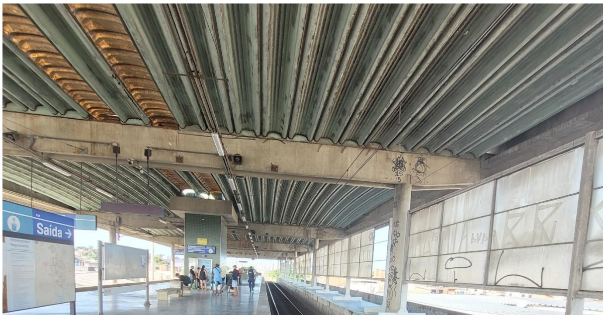
Foto 3-193: Cobertura da estação apresenta oxidação com furos e domo opaco
