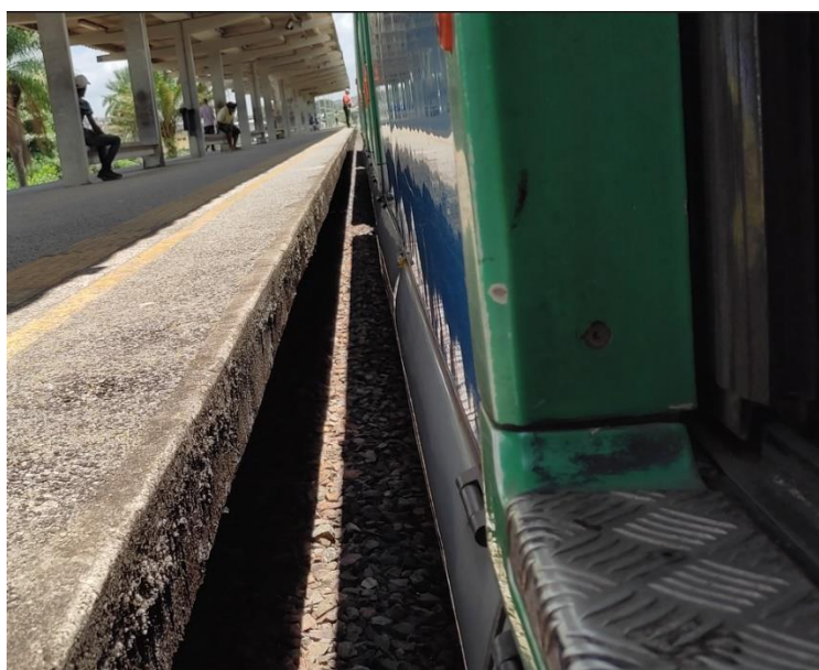
Foto 4-28: Vão entre o trem e a plataforma excessivo
