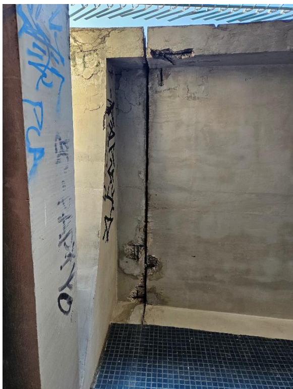
Foto 2-57: Passarela e Mezanino Operacional – Lajes com infiltração e ferragens expostas
