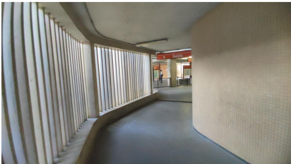
Foto 2-172: Rampas com desnível por lance maior que o permitido pela Norma, faltam elementos de acessibilidade
