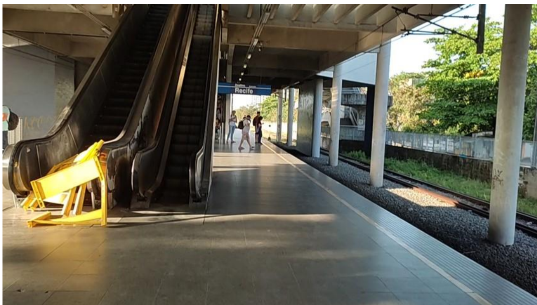
Foto 3-108: Escadas rolantes de acesso à plataforma. Apenas uma operante
