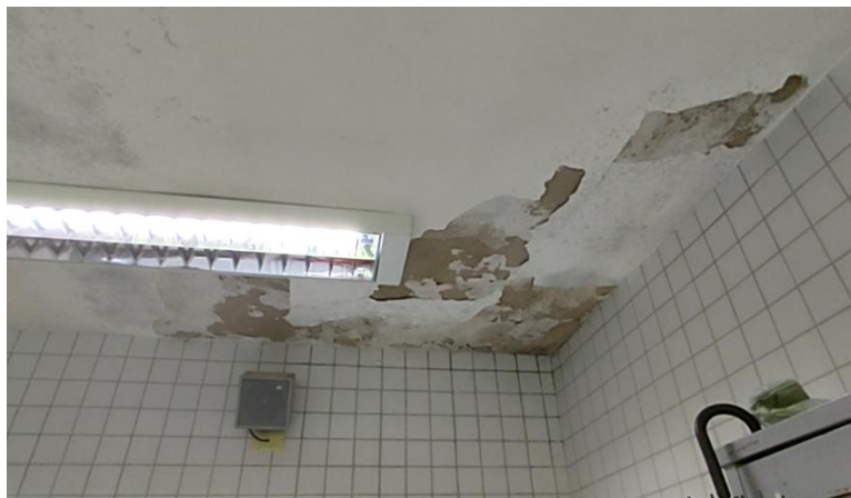
Foto 2-241: Vestiários integrados com sanitários são pequenos, apresentam infiltração e alguns equipamentos quebrados (exemplo mictório)
