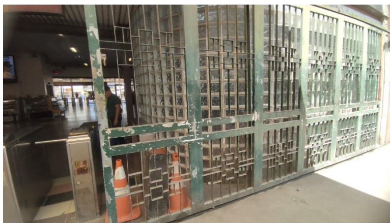
Foto 2-253: Portão com ferrugens e necessidade de pintura
