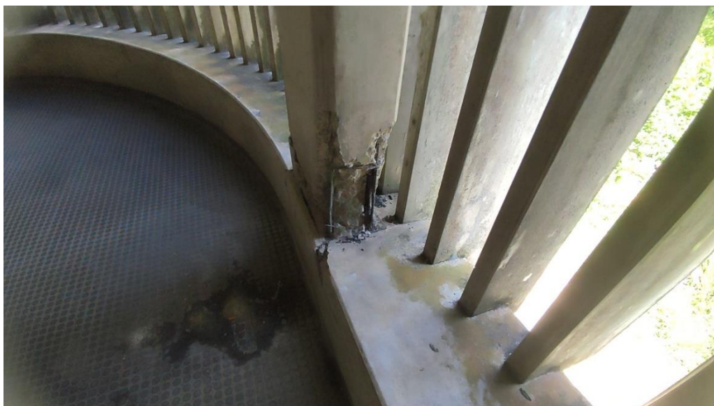
Foto 2-171: Ferragem exposta na base de pilar
