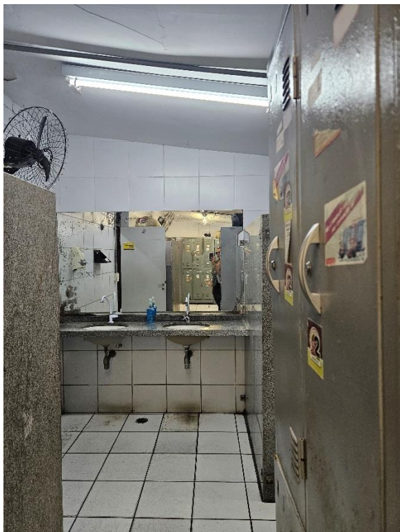
Foto 2-11: Sanitário e Vestiário Operacional – Infiltrações, Revestimentos danificados, Ausência de Elementos
