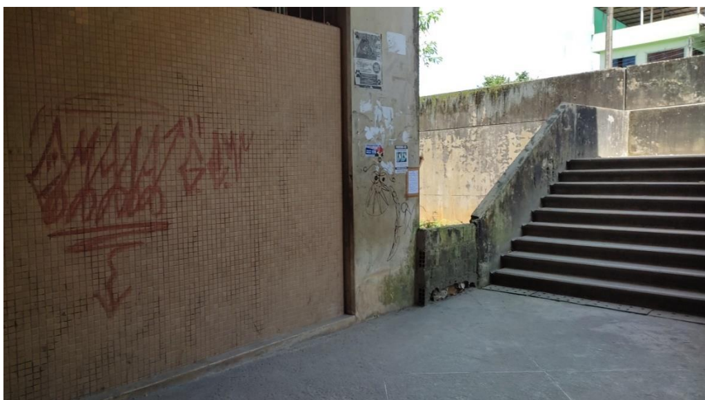
Foto 2-176: Pichações, Lodo, infiltrações. Escada sem elementos de acessibilidade
