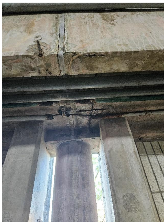
Foto 2-146: Pilar Torto, ferragem exposta e infiltração na viga
