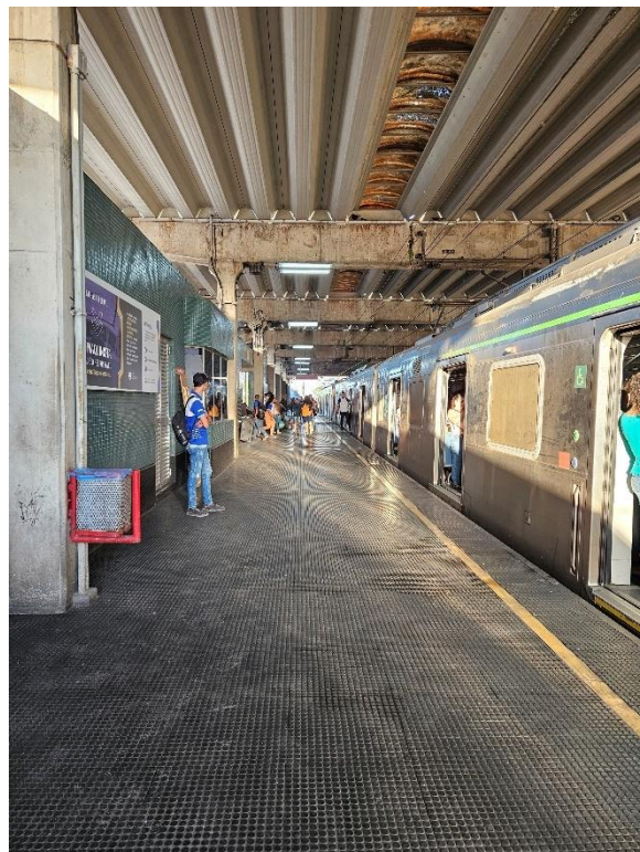
Foto 2-96: Ausência de Rota tátil e elementos de acessibilidade
