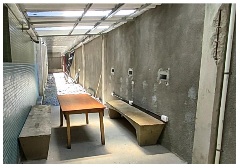
Foto 2-26: Área Operacional – Ferragem exposta, necessidade de pintura
