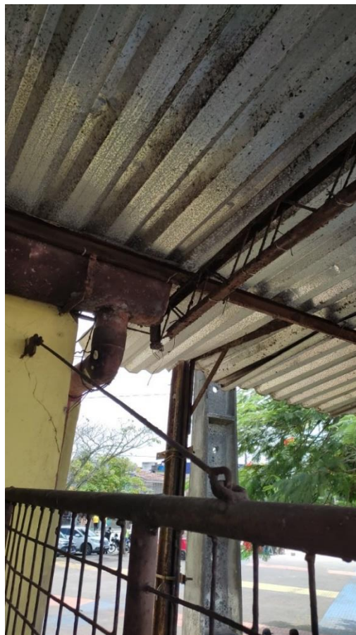
Foto 4-11: Calhas oxidadas, com furos
