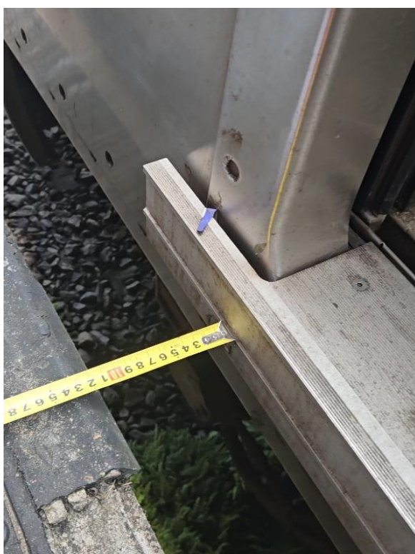
Foto 2-139: Plataformas 2Bis sentido Recife – vão 11cm maior que o permitido na Norma, bancos degradados
