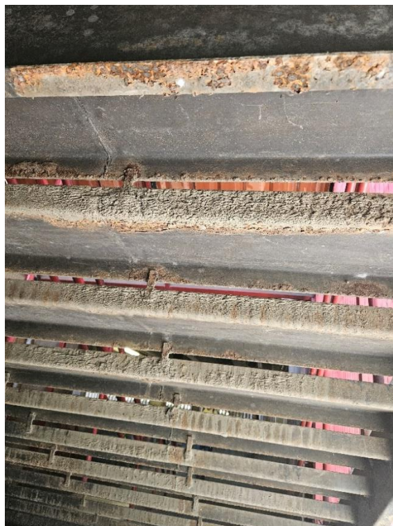
Foto 2-109: Área Inferior da Escada da Integração – Piso degradado, ferrugem nos degraus e vigas
