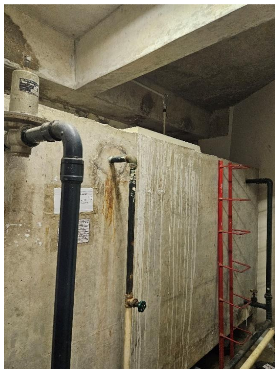
Foto 2-82: Salas Técnicas - Infiltração nas paredes, vigas e lajes
