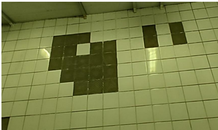
Foto 2-27: Copa – Revestimento cerâmico degradado
