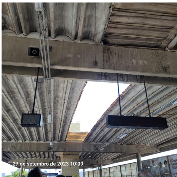
Foto 3-174: Trecho da cobertura da plataforma destelhado
