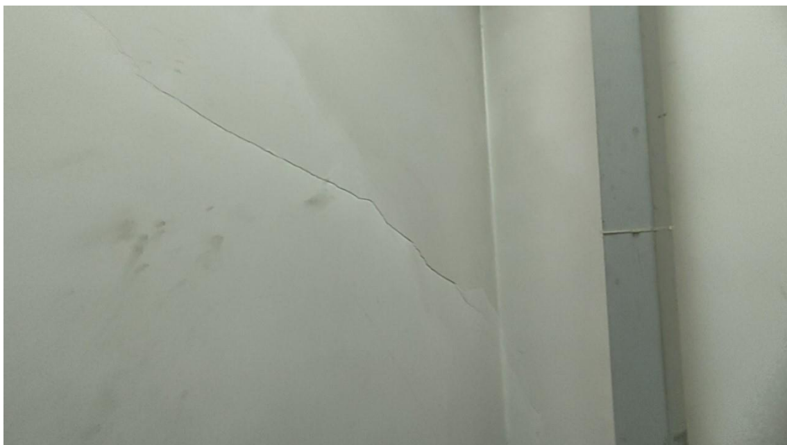
Foto 3-40: Fissura diagonal em parede
