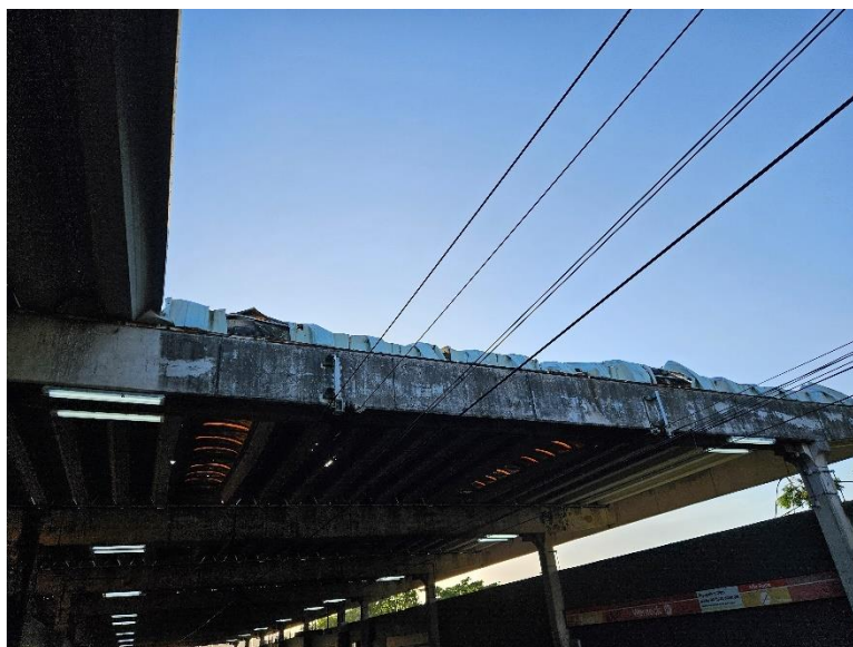
Foto 2-92: Faltando trecho da cobertura Plataformas
