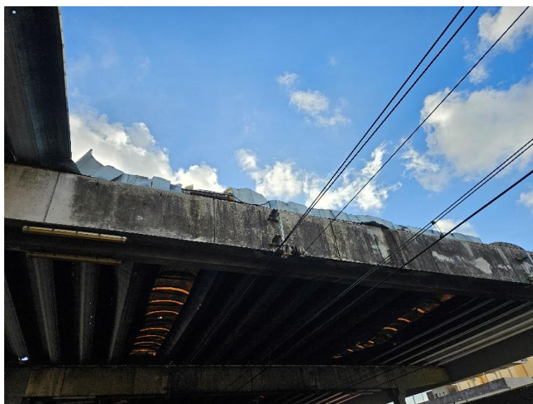
Foto 2-84: Necessidade de limpeza e tratamento do concreto aparente
