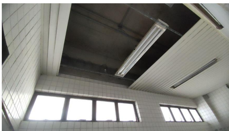
Foto 2-256: Salas Técnicas e Operacionais – Forro degradado e peças faltantes
