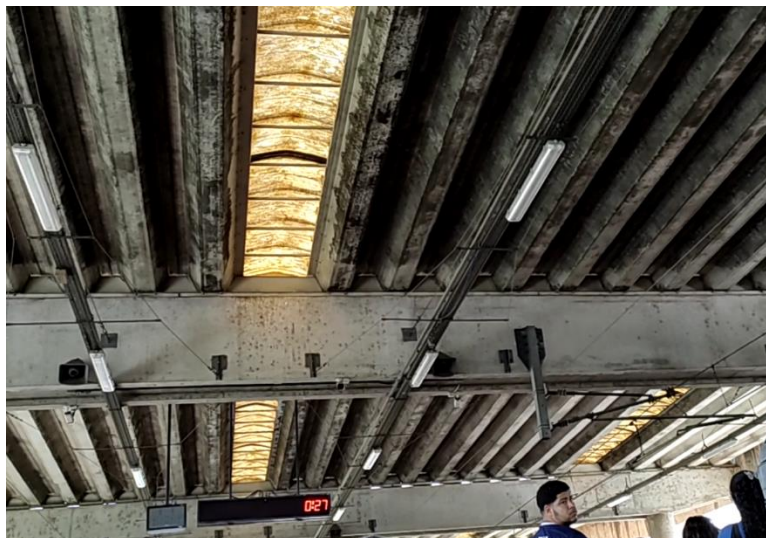
Foto 2-258: Cobertura – Necessidade de limpeza do Domus e telhas, alguns pontos necessitam de manutenção. Calhas entupidas
