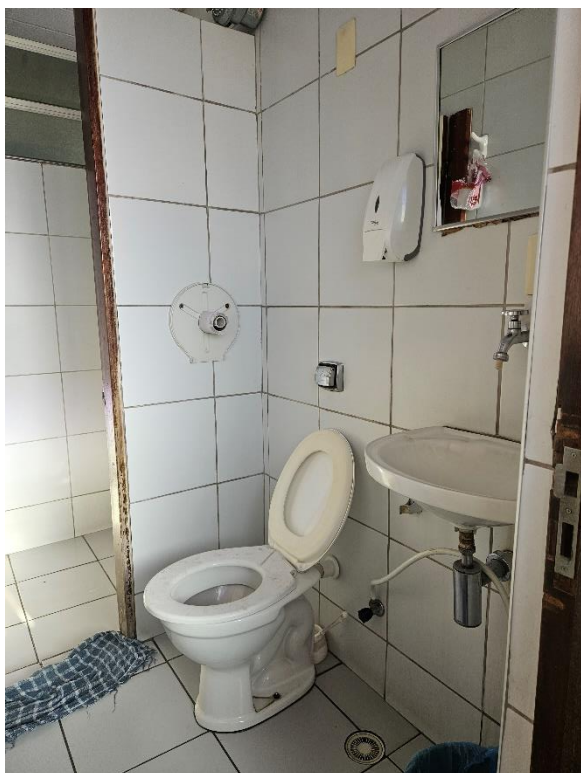
Foto 2-59: Sanitários Operacionais – Pequenos e sem ventilação. Vestiários Operacionais – Sem chuveiro, sem ventilação, não integrado aos sanitários
