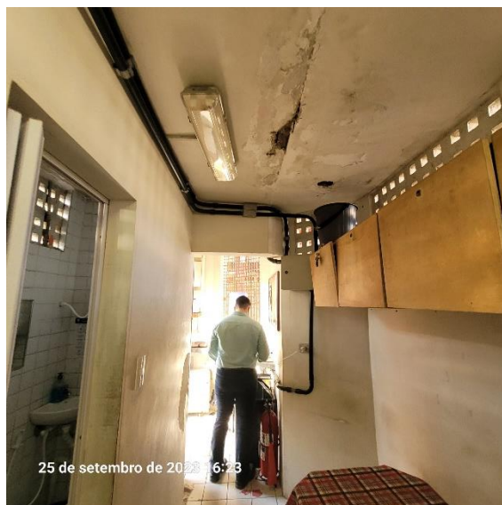
Foto 4-70: Salas técnicas com ferragem exposta na laje
