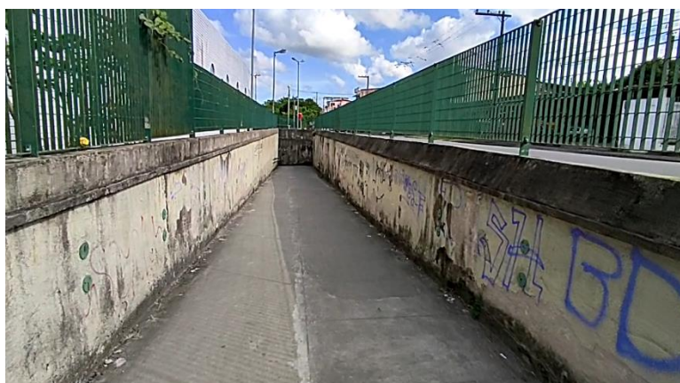
Foto 2-233: Rampa de Acesso sem patamares intermediários, sem corrimãos, pichações e infiltrações
