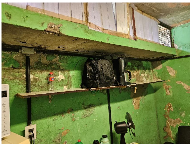
Foto 2-137: Copa – infiltrações, ferragens expostas, sem ventilação natural
