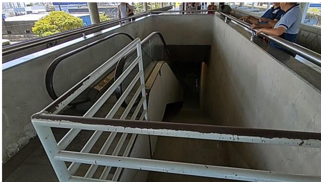
Foto 3-56: Corrimão necessitando de pintura
