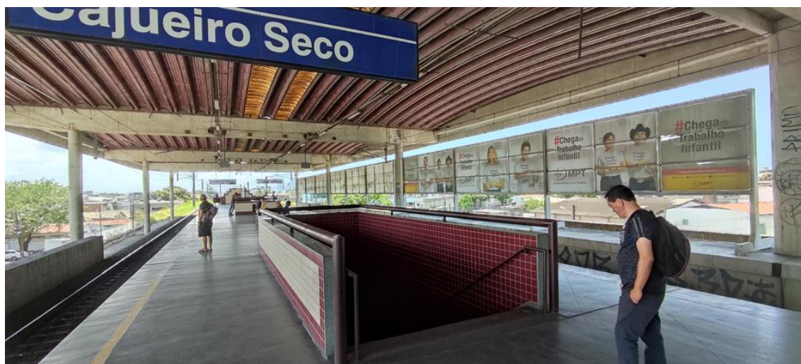
Foto 3-151: Ausência de rota tátil na plataforma
