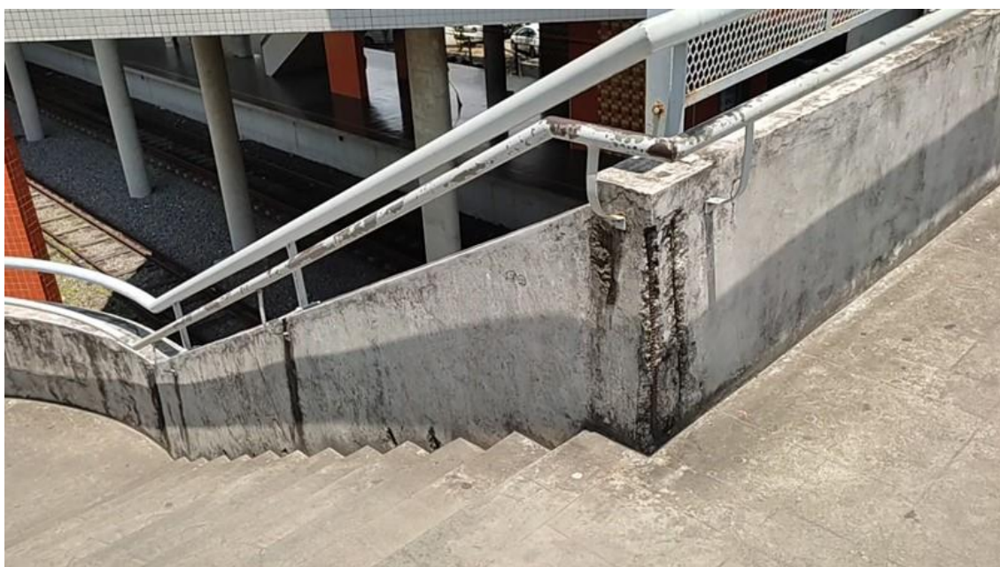
Foto 3-93: Corrimões necessitando de pintura e apresentando problemas de acessibilidade. Armadura exposta na estrutura de concreto armado
