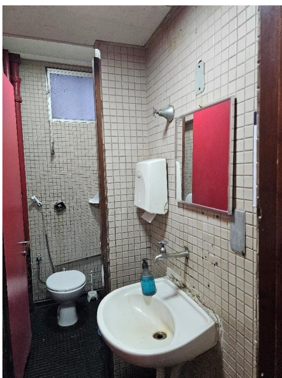
Foto 2-97: Sanitários Operacionais – Pequenos e sem ventilação. Vestiários Operacionais – Sem chuveiro, sem ventilação, não integrado aos sanitários
