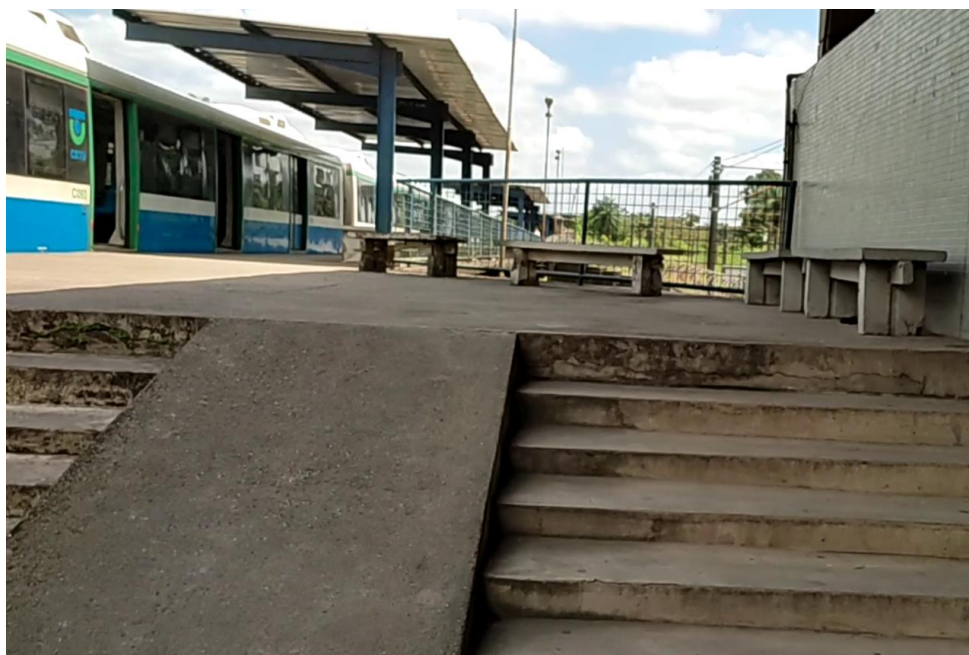
Foto 2-209: Escada e Rampa não atendem as Normas de Acessibilidade
