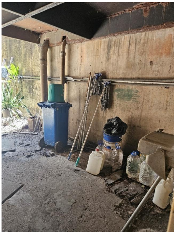
Foto 2-109: Área Inferior da Escada da Integração – Piso degradado, ferrugem nos degraus e vigas
