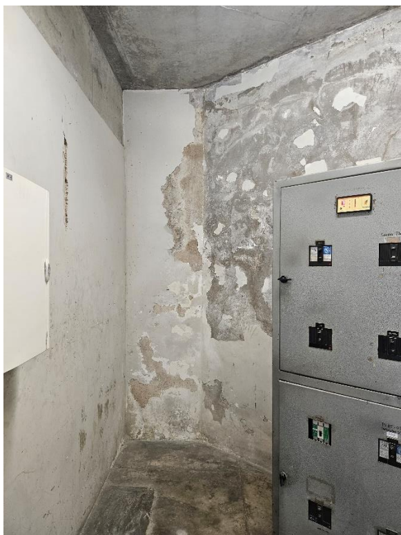
Foto 2-12: Salas Técnicas – Infiltrações, Revestimentos danificados, Rachaduras
