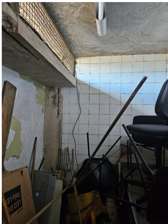
Foto 2-219: Salas Operacionais – Revestimentos degradados, infiltrações, ferragens expostas, instalações elétricas improvisadas
