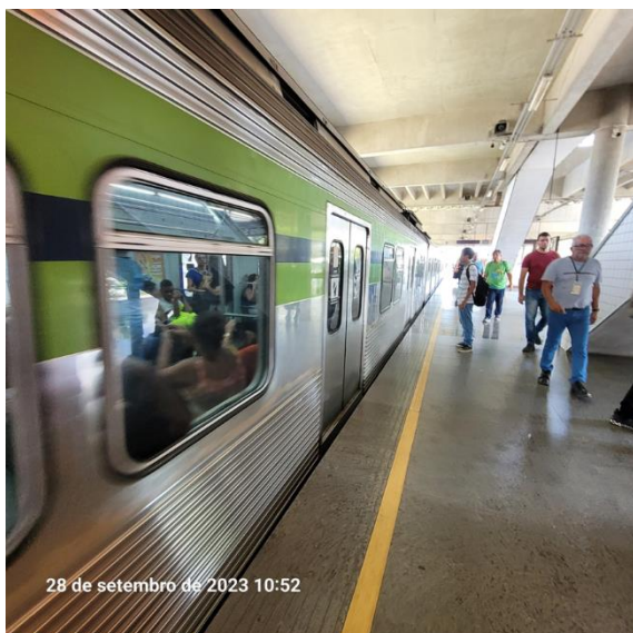
Foto 3-83: Vãos horizontal e vertical inadequados. Ausência de rota tátil
