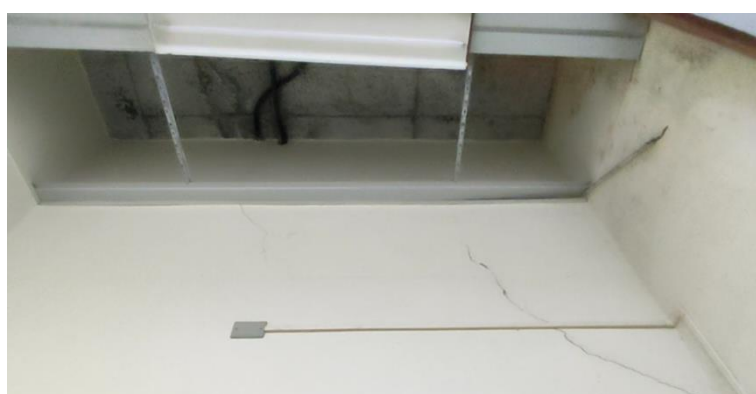
Foto 2-25: Rachaduras e Infiltrações nas Salas Operacionais
