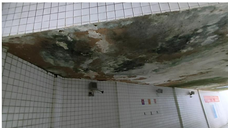
Foto 2-235: Infiltração na Laje
