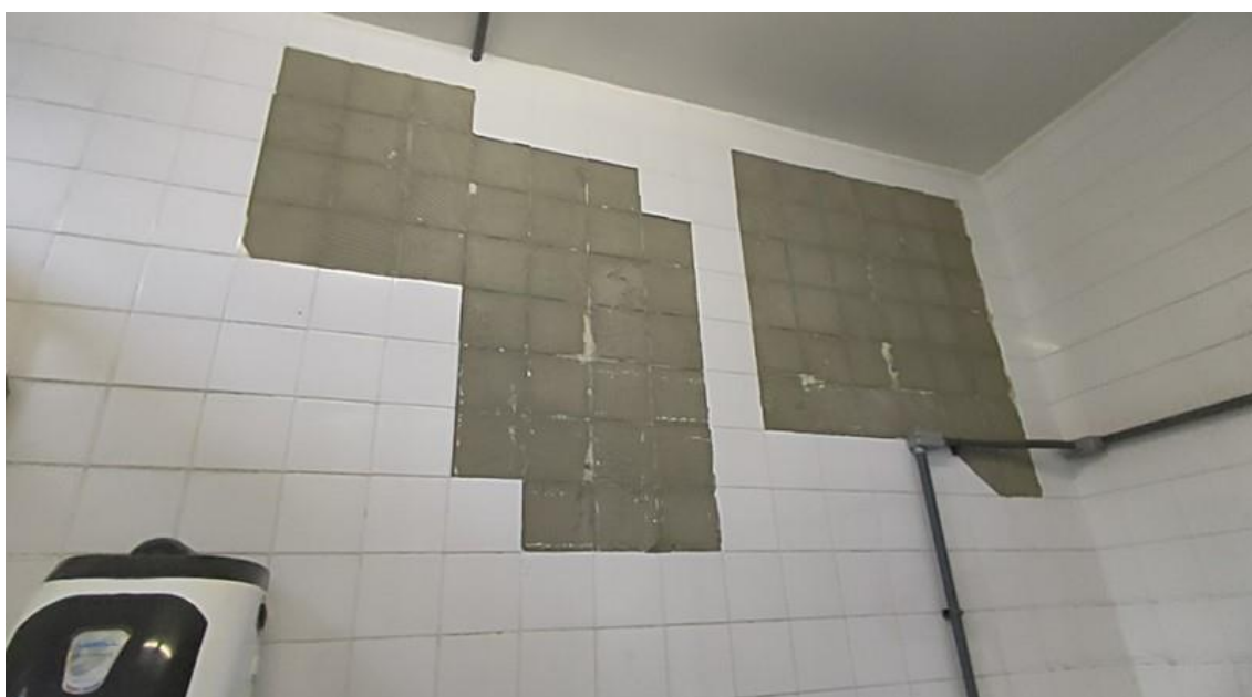
Foto 3-156: Azulejo de parede deslocado na área da copa
