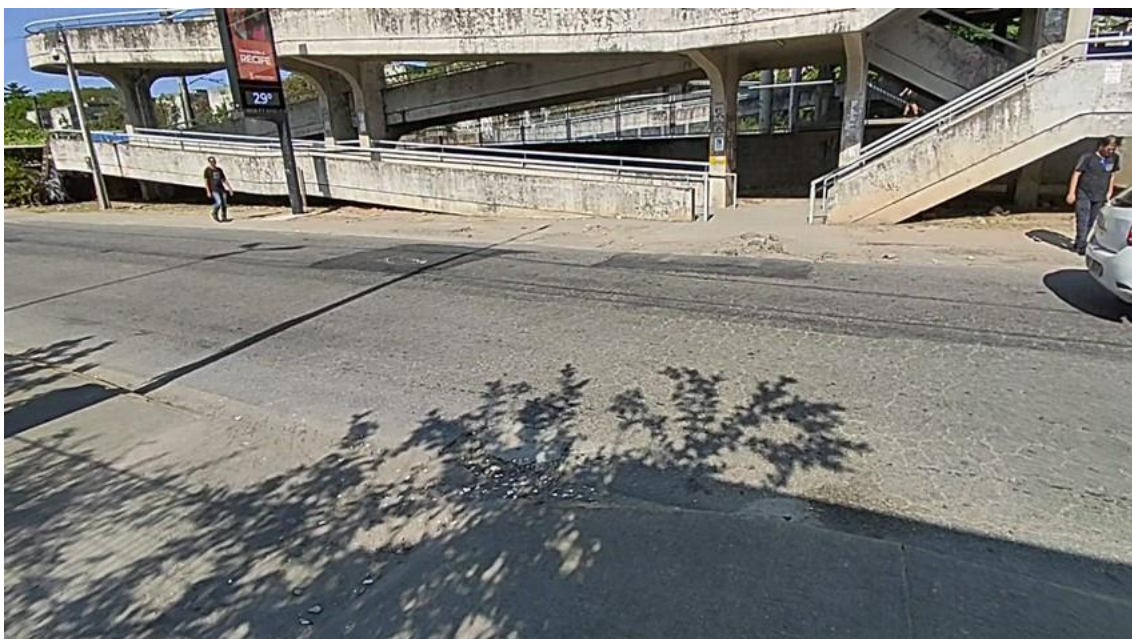
Foto 3-120: Ausência de guia rebaixada e piso tátil no entorno; falta de sinalização horizontal e vertical
