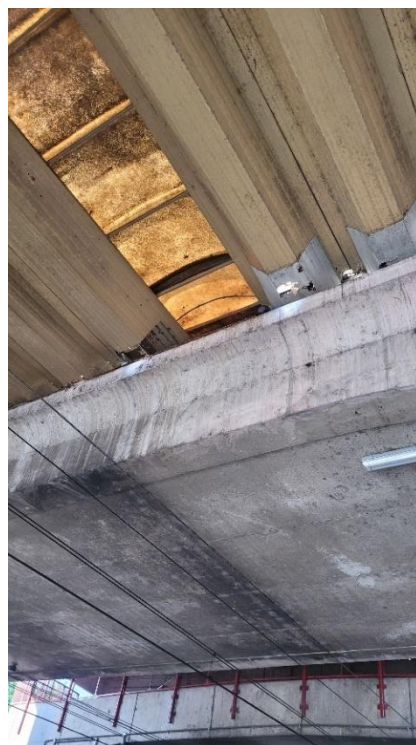
Foto 2-122: Plataformas – Ausência de Rota Tátil, infiltrações, telhas e Domus danificados
