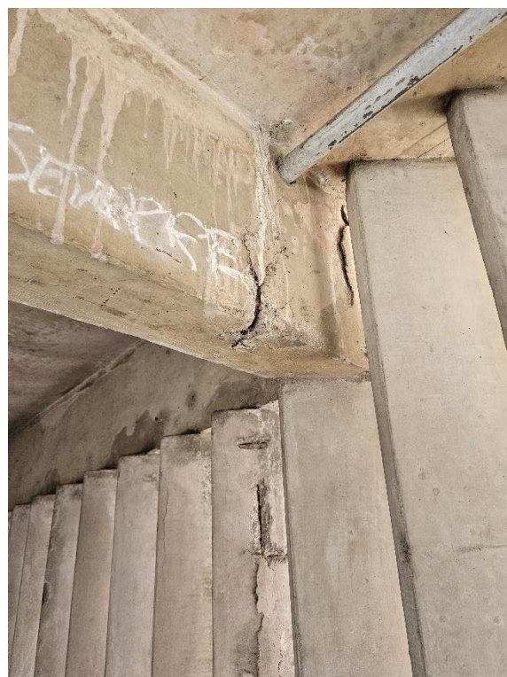
Foto 2-131: Ferragens expostas em lajes e vigas
