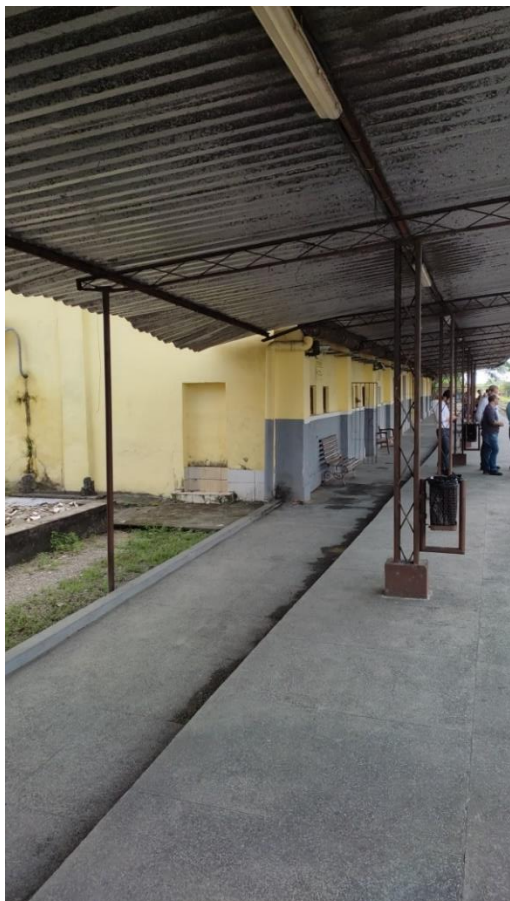
Foto 4-10: Telhas metálicas necessitando de recuperação
