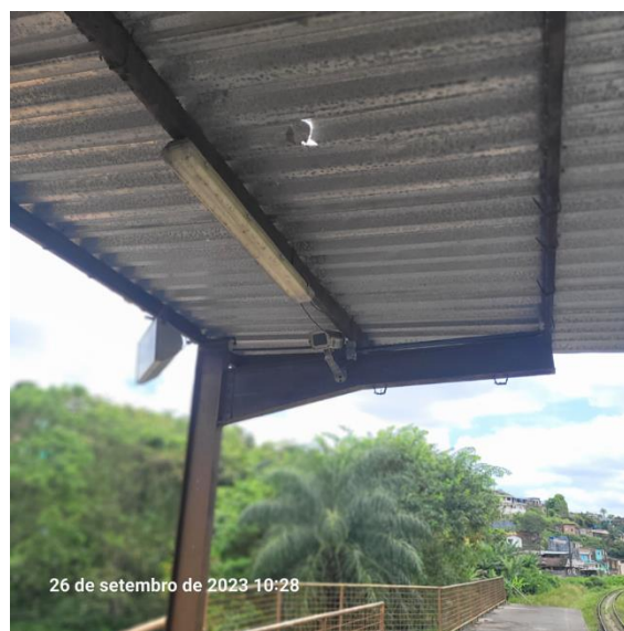
Foto 4-90: Telhado da cobertura com buracos
