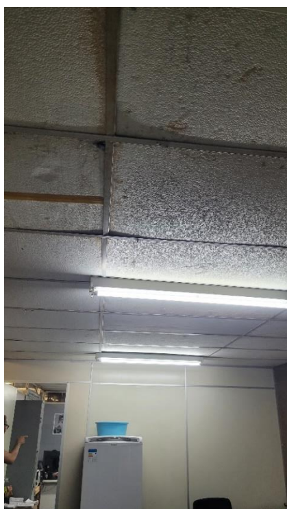
Foto 2-125: Instalações adaptadas nas salas administrativas, forros e revestimentos degradados
