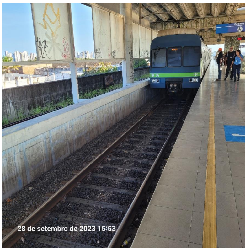
Foto 3-14: Painéis danificados. Ausência de piso tátil da faixa amarela
