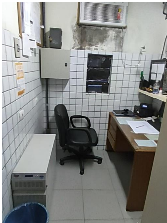
Foto 4-78: Parede de sala técnica degradadas devido à infiltração
