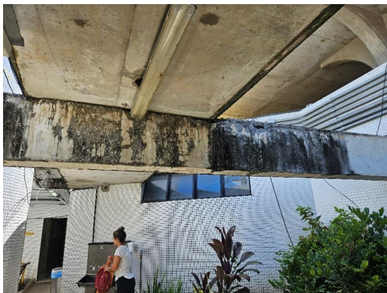
Foto 2-13: Pátio Área Operacional – Infiltrações, Rachaduras
