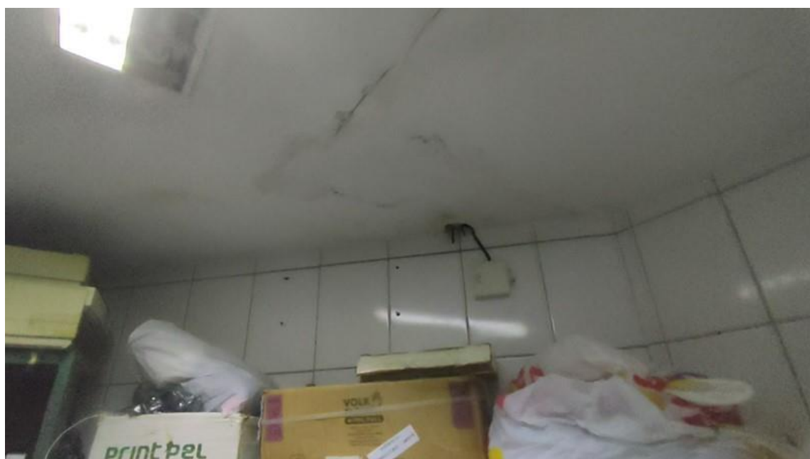
Foto 3-91: Laje apresentando intensa fissuração
