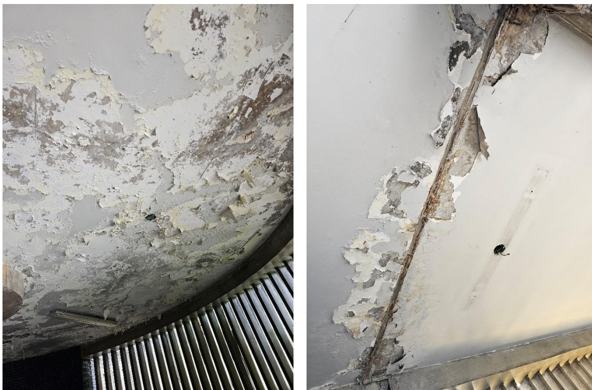
Foto 2-36: Rampa de Acesso à Plataforma – Infiltrações, Bicheira, Ausência de Luminárias
