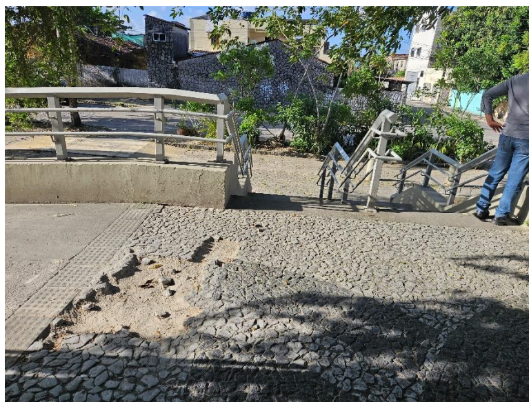
Foto 2-52: Piso de acesso a Estação degradado
