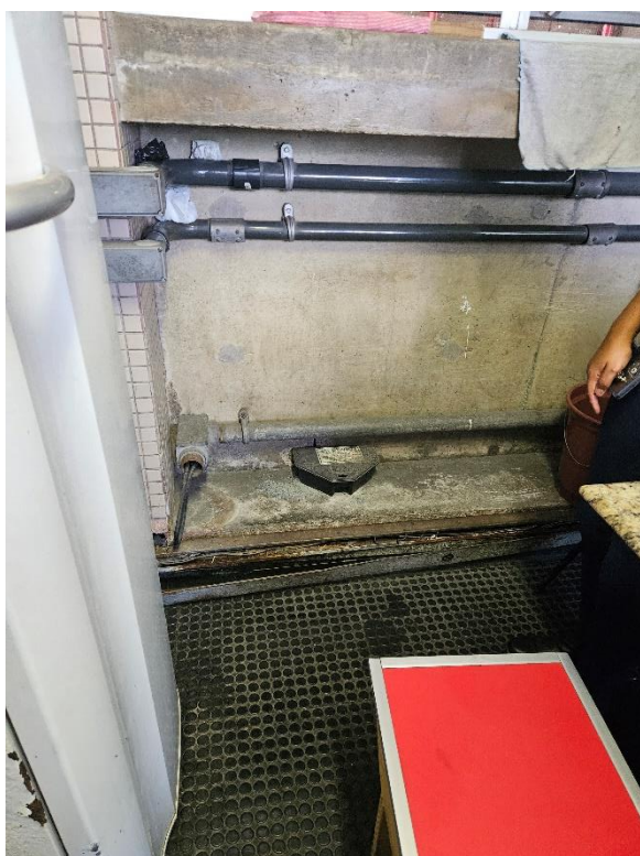
Foto 2-86: Salas Operacionais – Elétrica improvisada, acabamentos danificados etc.
