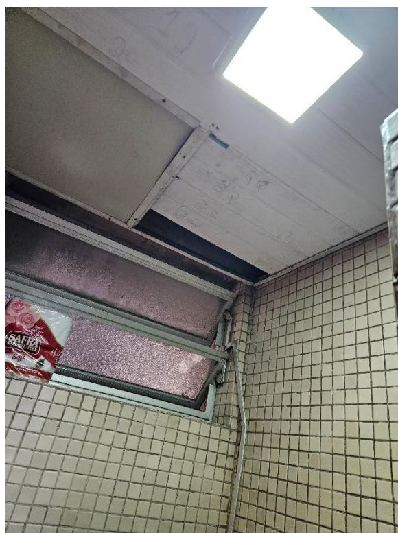
Foto 2-86: Salas Operacionais – Elétrica improvisada, acabamentos danificados etc.
