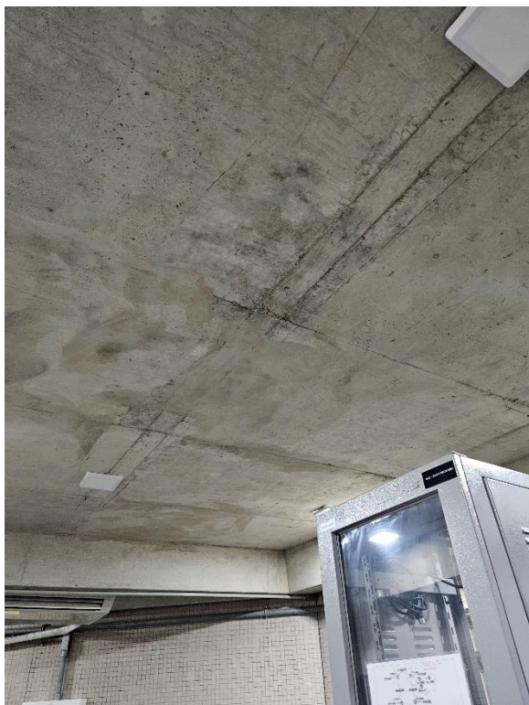
Foto 2-50: Salas Técnicas - Infiltrações
