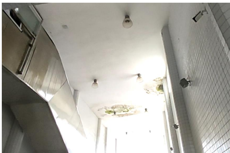
Foto 2-237: Infiltração no Teto
