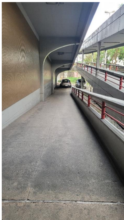
Foto 2-124: Rampa de Acesso a Passarela – Desnível do Lance maior que o permitido na Norma. Rampas e Escadas – ausência de elementos de acessibilidade
