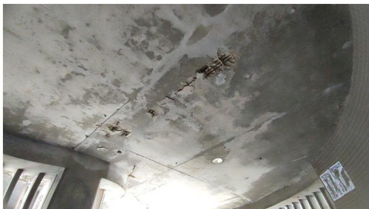
Foto 2-24: Infiltrações e ferragens expostas em lajes de cobertura
