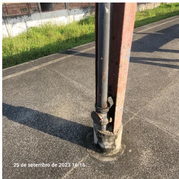
Foto 4-66: Pilares do telhado da estação oxidados e danificados
