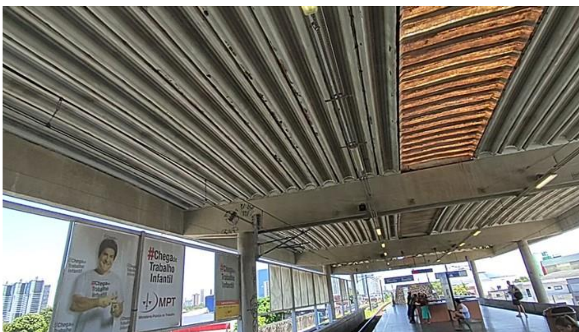
Foto 3-55: Telhas da cobertura apresentando alto grau de oxidação e falta de placas no anteparo
