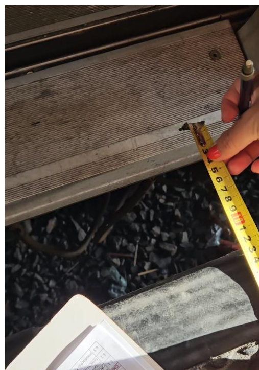
Foto 2-72: Plataforma – Vão entre trem em Plataforma sentido Recife 12 cm e sentido Jaboatão Camaragibe 13 cm, ambos fora de Norma.
