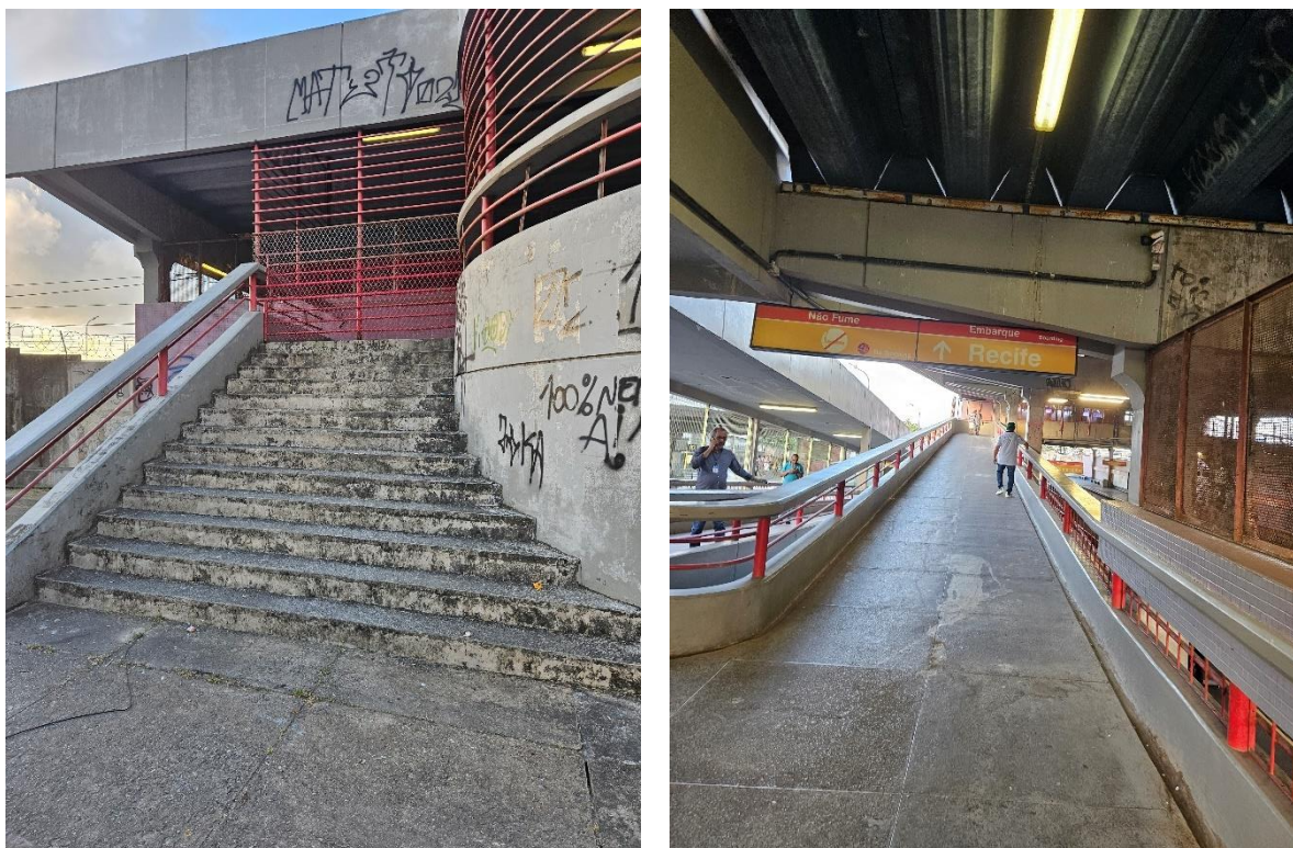
Foto 2-87: Escada Interditada e faltam elementos de acessibilidade. Rampa com desnível por lance maior que o permitido.
