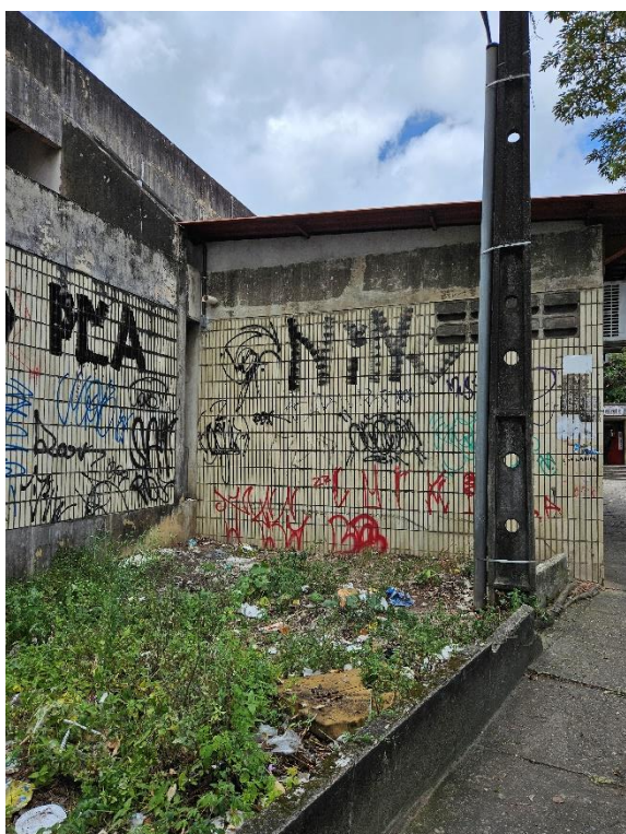
Foto 2-135: Estação quase que em sua totalidade pichada, necessita de tratamento no concreto aparente e apresenta calçadas danificadas
