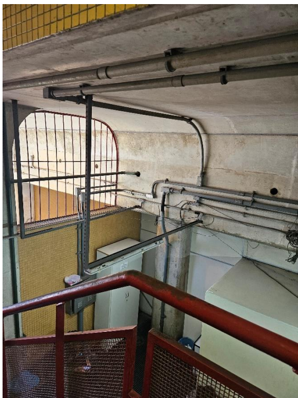
Foto 2-105 Salas Operacionais – Necessidade de Pintura, Fios Elétricos inadequados
