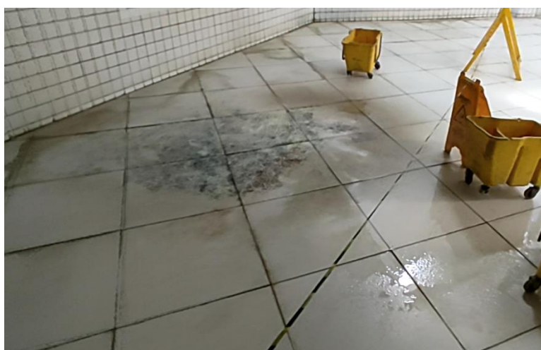
Foto 2-236: Infiltração no piso
