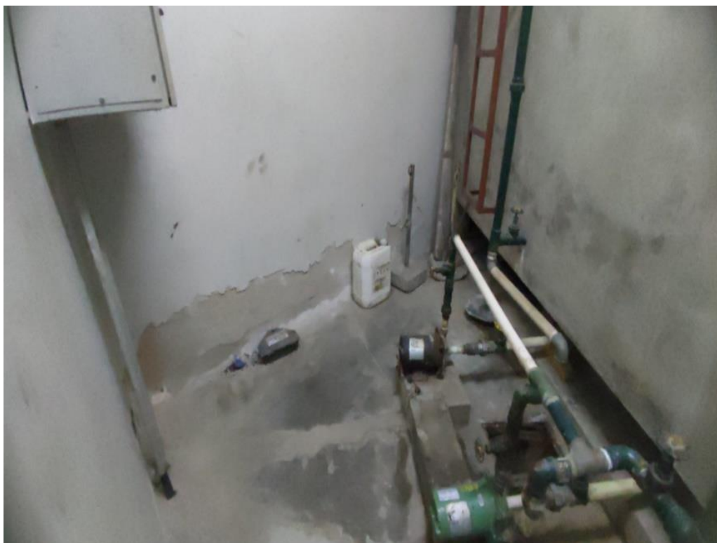
Foto 2-161: Salas Técnicas – infiltrações
