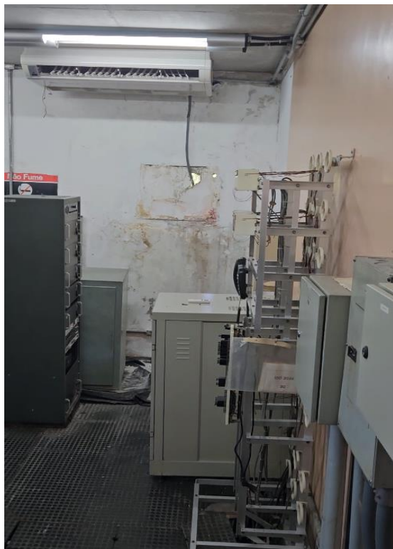
Foto 2-221: Infiltração em parede de sala técnica, rachadura na laje
