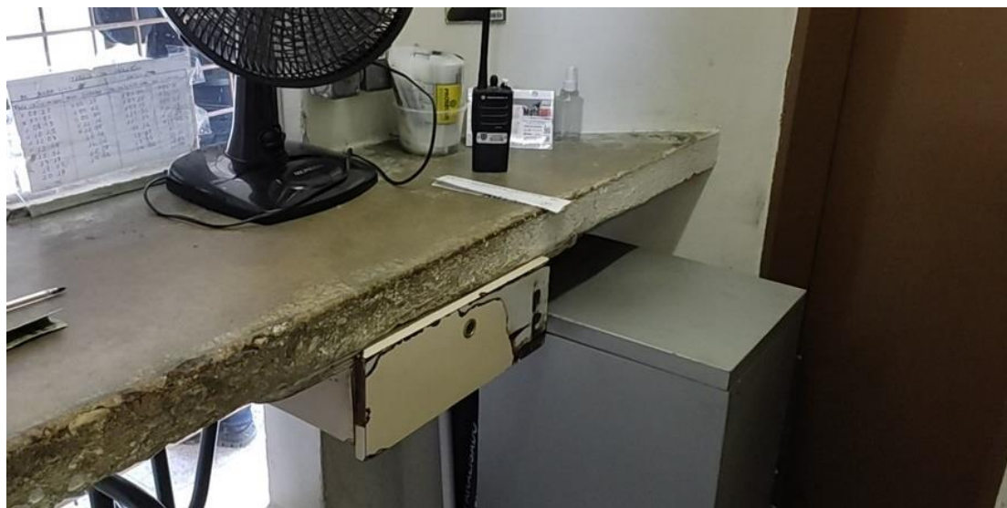
Foto 4-94: Balcão em concreto armado da bilheteria desgastado
