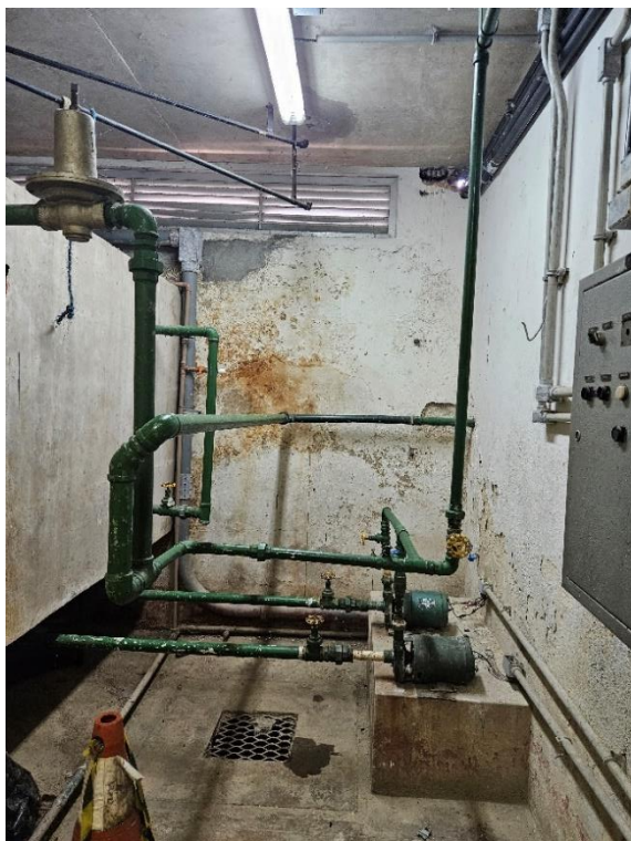
Foto 2-106: Salas Técnicas – Infiltrações
