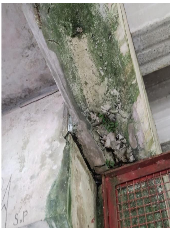
Foto 2-160: Rampas – Infiltrações, bicheiras, ferragens expostas
