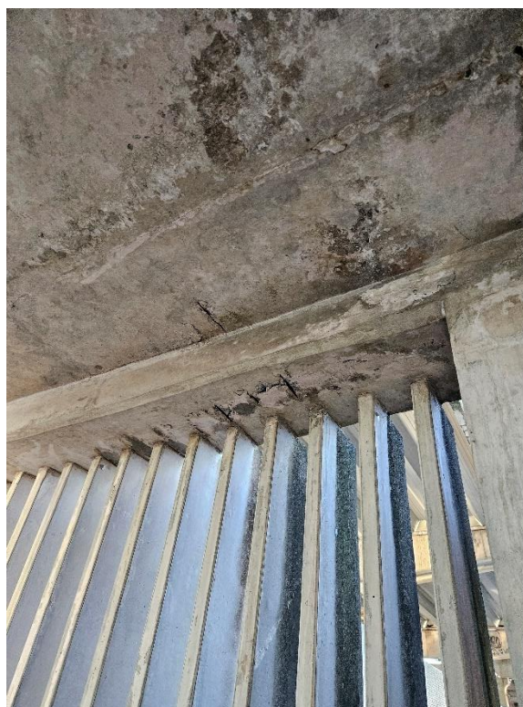
Foto 2-95: Rampa de Acesso a Plataforma - Ferragens expostas, infiltrações
