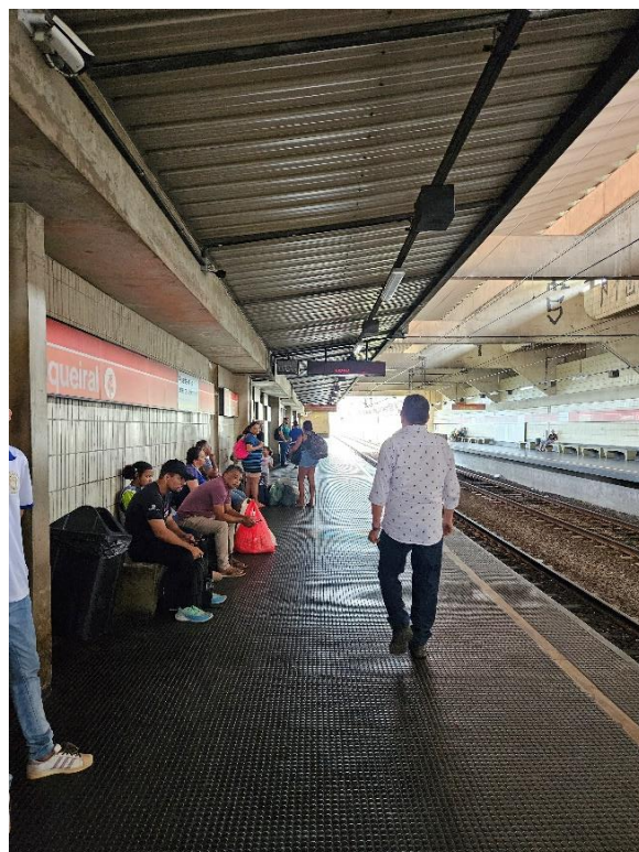
Foto 2-138: Plataformas sem rota tátil e elementos de acessibilidade
