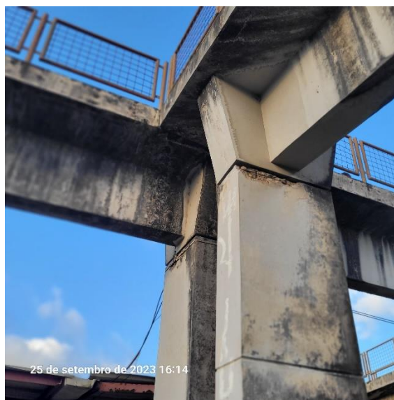
Foto 4-65: Pilares da passarela apresentando problemas no concreto e ferragens expostas
