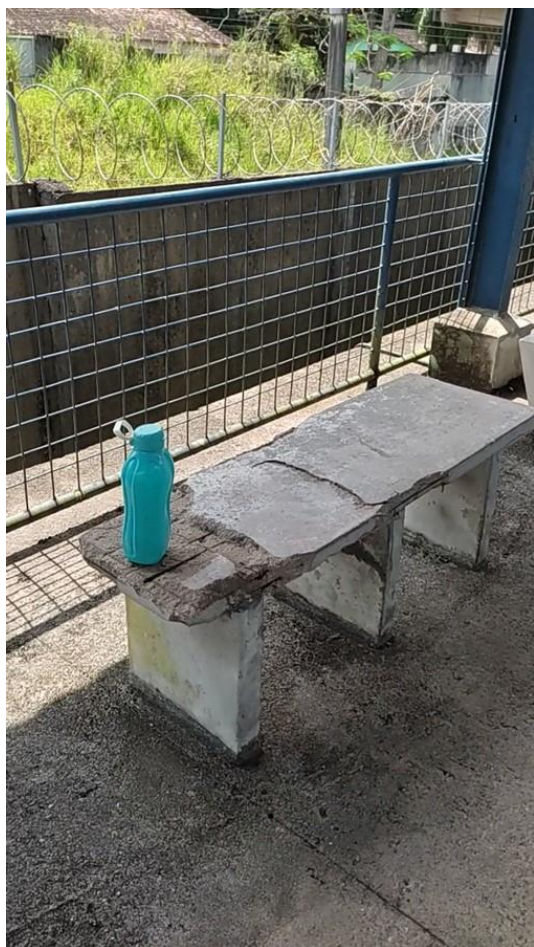
Foto 4-104: Assento em concreto armado deteriorado
