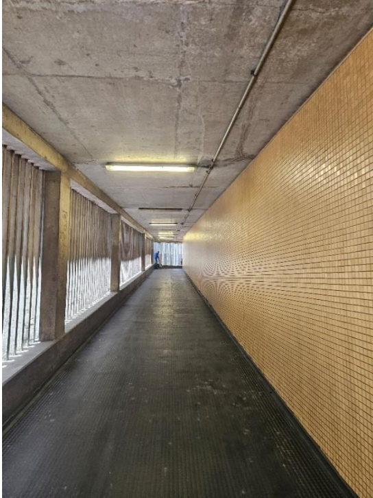
Foto 2-116: Rampa de Acesso a Plataforma – Desnível do Lance maior que o permitido na Norma, Piso danificado e infiltrações
