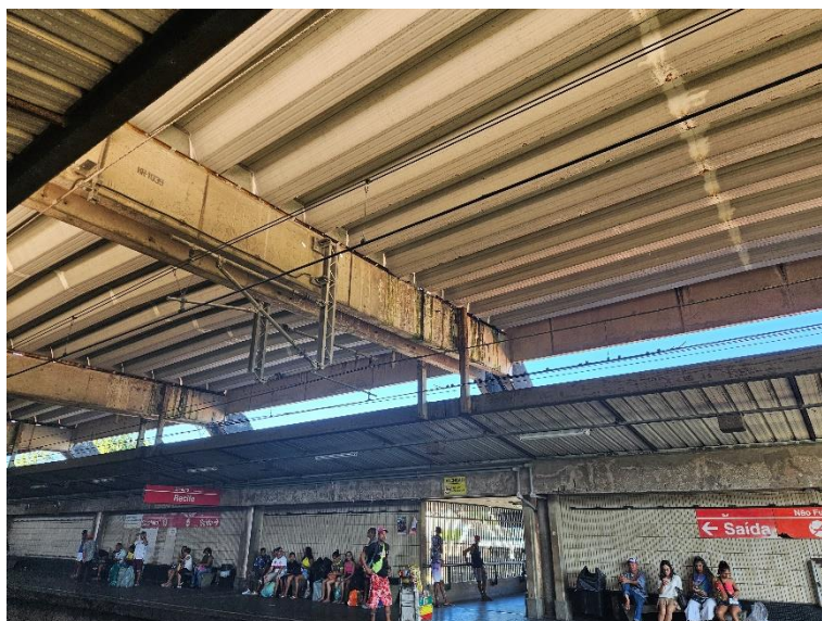
Foto 2-145: Cobertura - Infiltrações, Lodo e Corrosões
