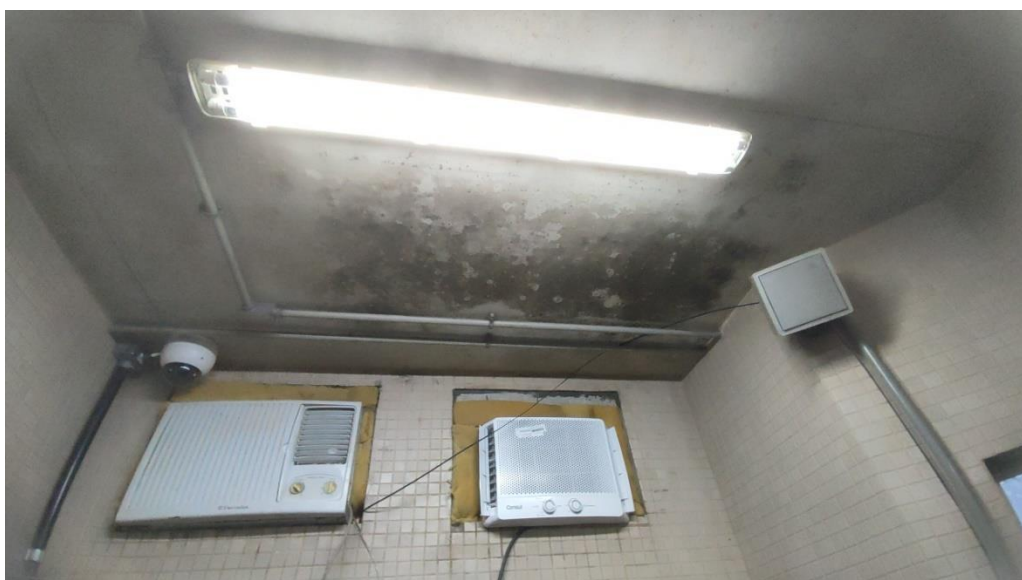
Foto 2-174: Infiltrações e revestimentos deteriorados nas Salas Operacionais e Técnicas
