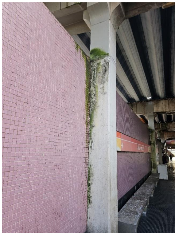
Foto 2-80: Infiltrações, trincas e bicheiras nos Pilares, Vigas e Paredes. Ausência de Rota Tátil.
