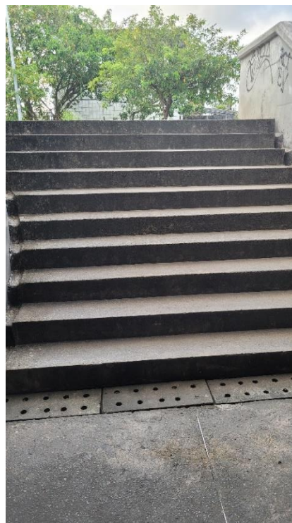
Foto 2-124: Rampa de Acesso a Passarela – Desnível do Lance maior que o permitido na Norma. Rampas e Escadas – ausência de elementos de acessibilidade
