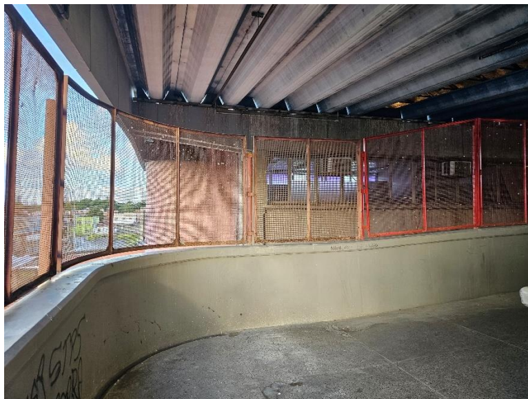
Foto 2-83: Telas de fechamento da plataforma de transposição das vias danificadas
