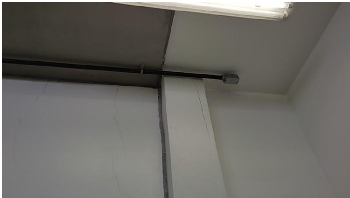
Foto 3-66: Fissuras nas paredes da Sala de Apontamento
