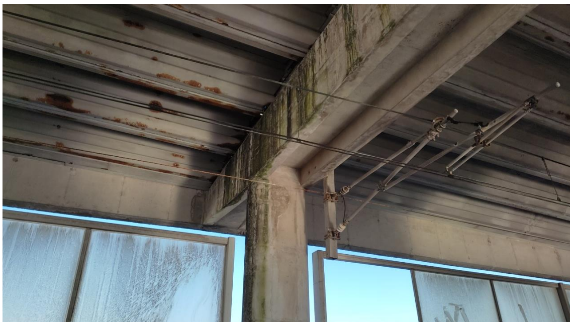
Foto 3-30: Viga de concreto armado com marcas de infiltração e perfis metálicos das telhas corroídos
