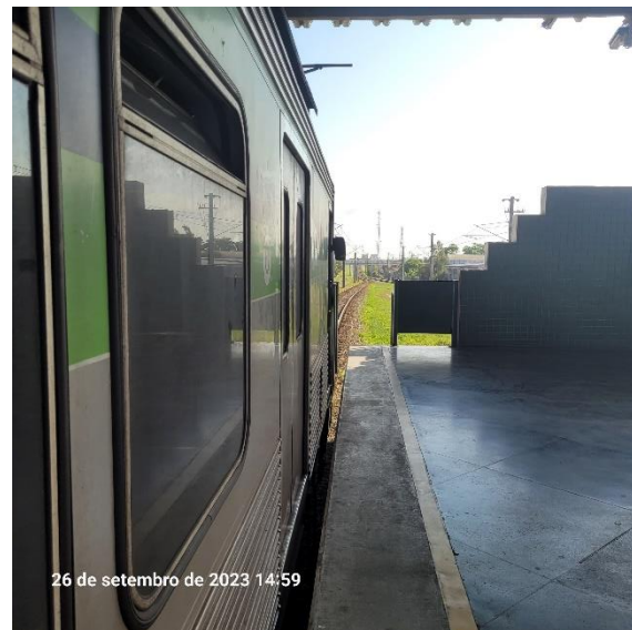
Foto 3-192: Vão excessivo entre o trem e a plataforma
