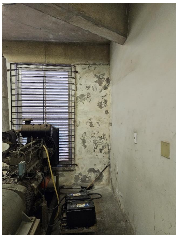
Foto 2-82: Salas Técnicas - Infiltração nas paredes, vigas e lajes
