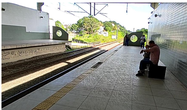
Foto 2-239: Plataforma – ausência de rota tátil e elementos de acessibilidade, pichações, placas de piso de alerta faltantes
