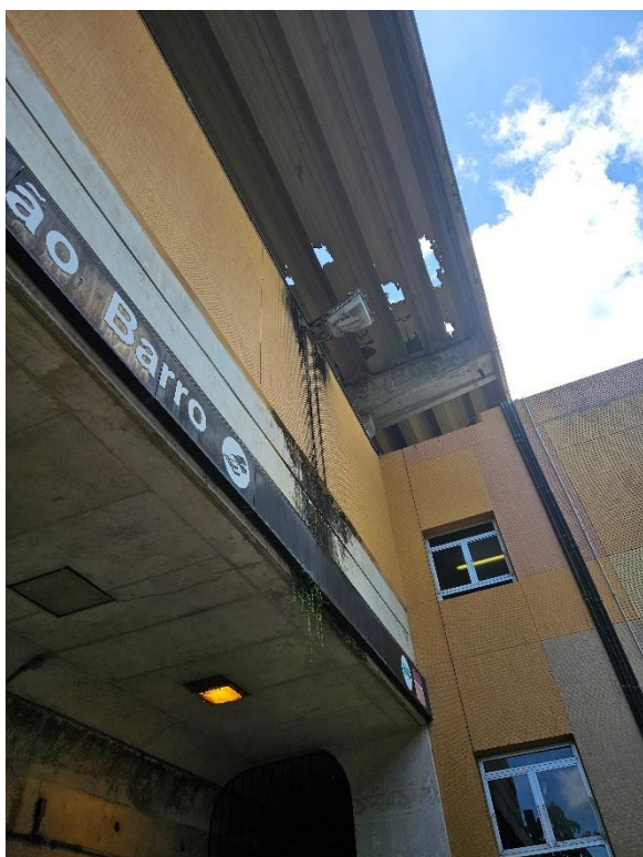
Foto 2-113: Acessos – Trincas e Infiltrações
