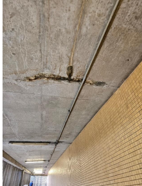
Foto 2-116: Rampa de Acesso a Plataforma – Desnível do Lance maior que o permitido na Norma, Piso danificado e infiltrações
