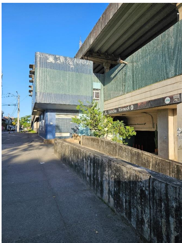
Foto 2-99: Necessidade de limpeza, tratamento do concreto aparente e rejuntamento de revestimento cerâmico de fachada
