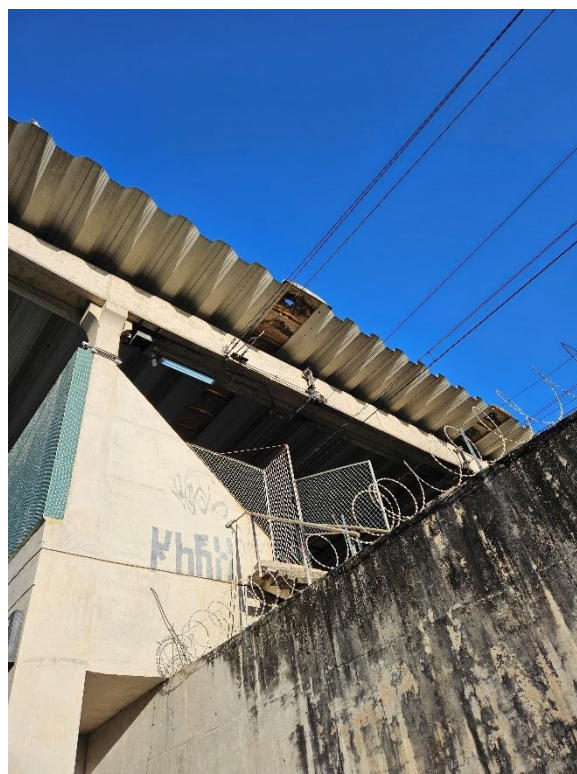
Foto 2-99: Necessidade de limpeza, tratamento do concreto aparente e rejuntamento de revestimento cerâmico de fachada
