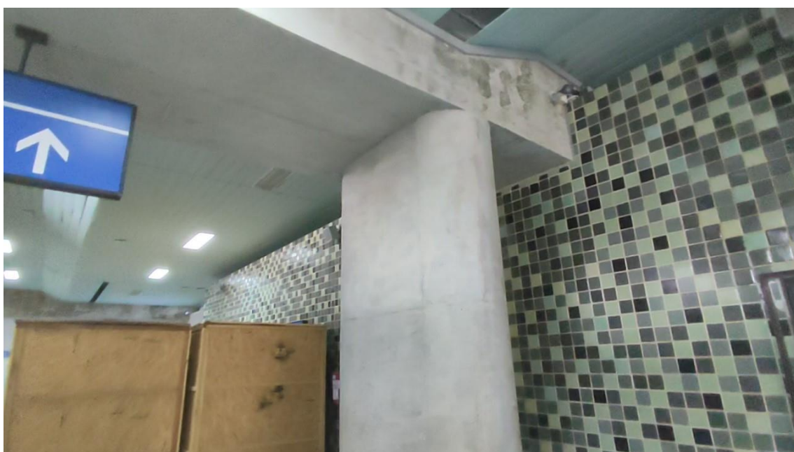
Foto 3-35: Estrutura de concreto armado no saguão com marcas da infiltração de água proveniente da via permanente
