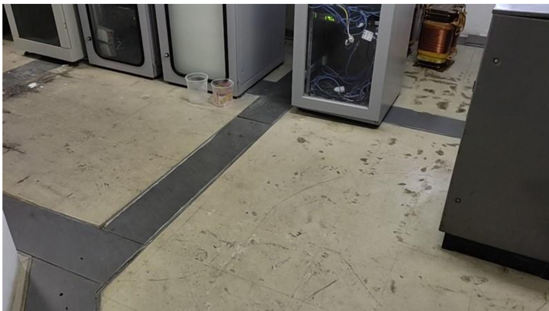
Foto 3-137: Piso cerâmico desgastado na Sala de Telecomunicações. Destaque para os baldes posicionados a fim de mitigar o problema de goteiras
