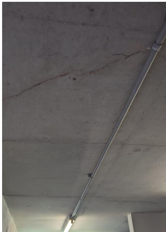
Foto 2-221: Infiltração em parede de sala técnica, rachadura na laje
