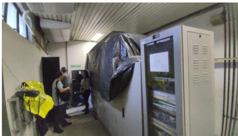
Foto 2-255: Salas Técnicas – Equipamentos cobertos com lona devido as infiltrações
