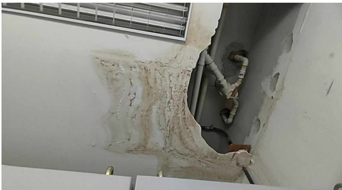
Foto 3-117: Infiltração pela tubulação hidráulica sobre o forro da sala
