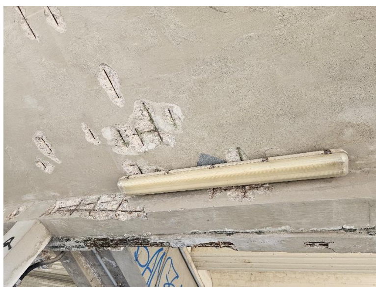
Foto 2-56: Passarela - Ferragens Expostas nas Vigas e Lajes
