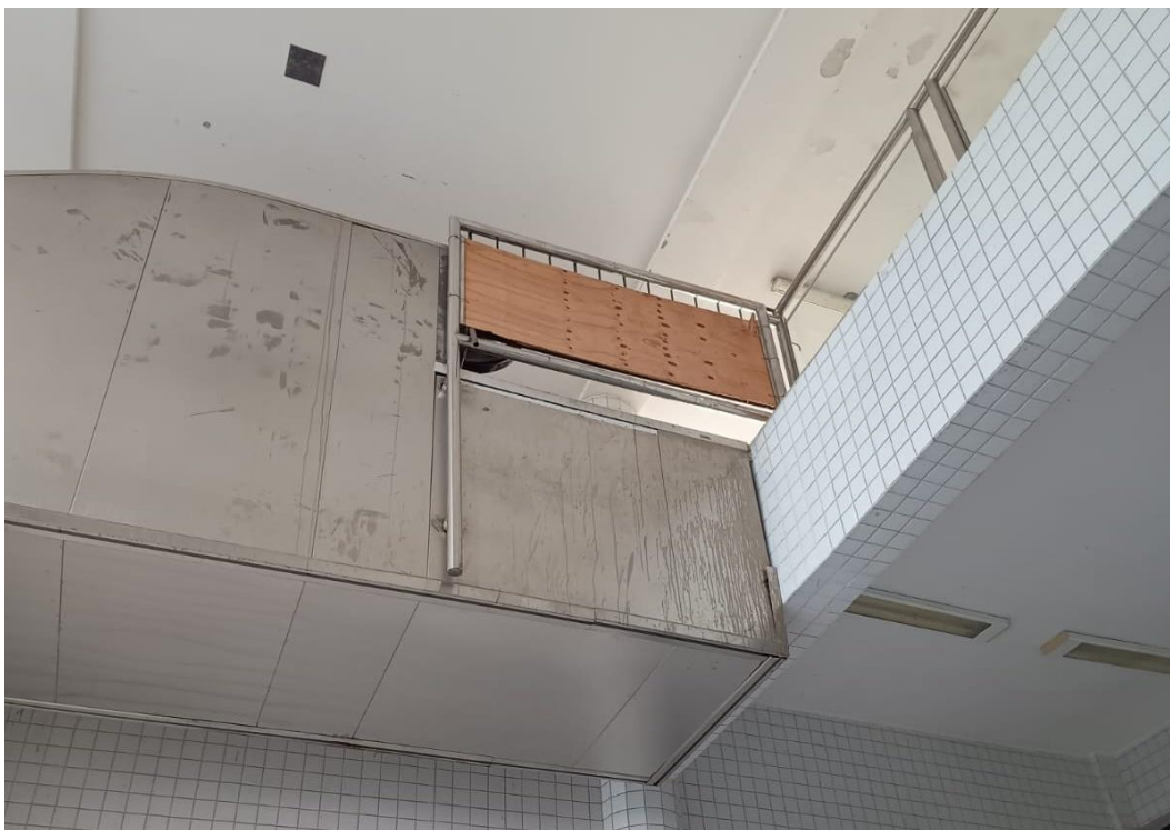
Foto 5-4: Escada rolante com um improviso para fechamento lateral – Estação Cosme e Damião
