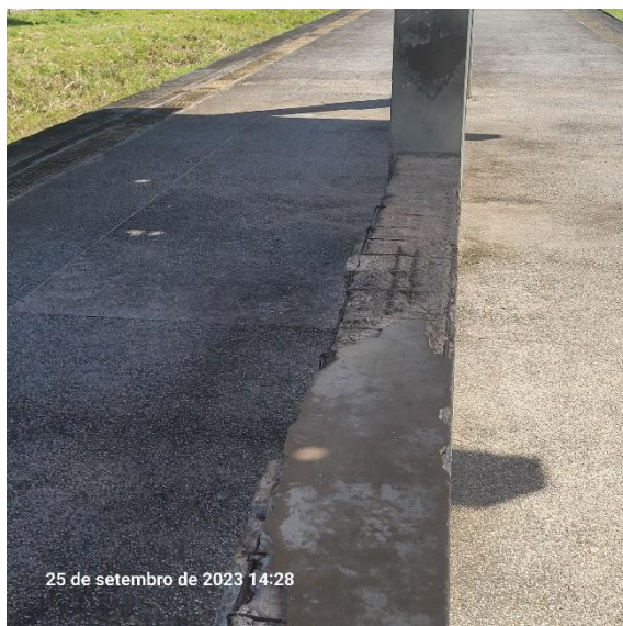
Foto 4-39: Mobiliário da plataforma (Banco), necessitando recuperação geral
