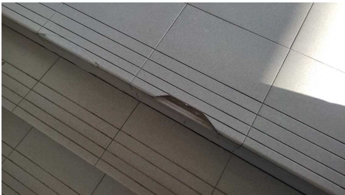
Foto 3-34: Material cerâmico da escada fixa danificado
