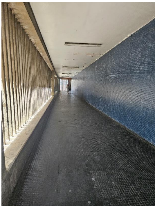
Foto 2-40: Rampas – Desnível por lance maior que permitido pela Norma. Infiltrações, bicheiras e ferragens expostas
