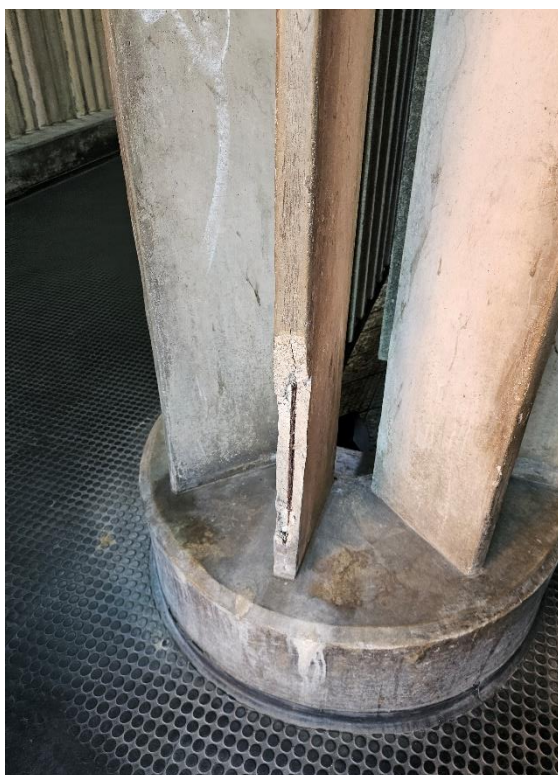
Foto 2-95: Rampa de Acesso a Plataforma - Ferragens expostas, infiltrações
