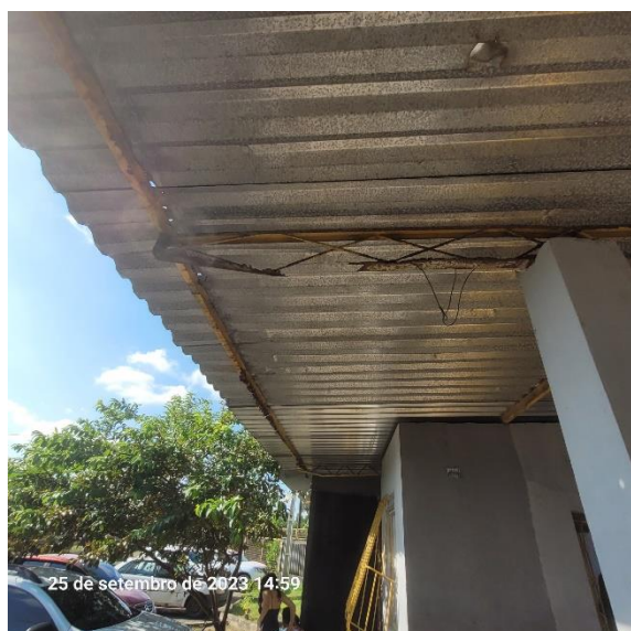
Foto 4-50: Estrutura das cobertas necessitando revisão geral
