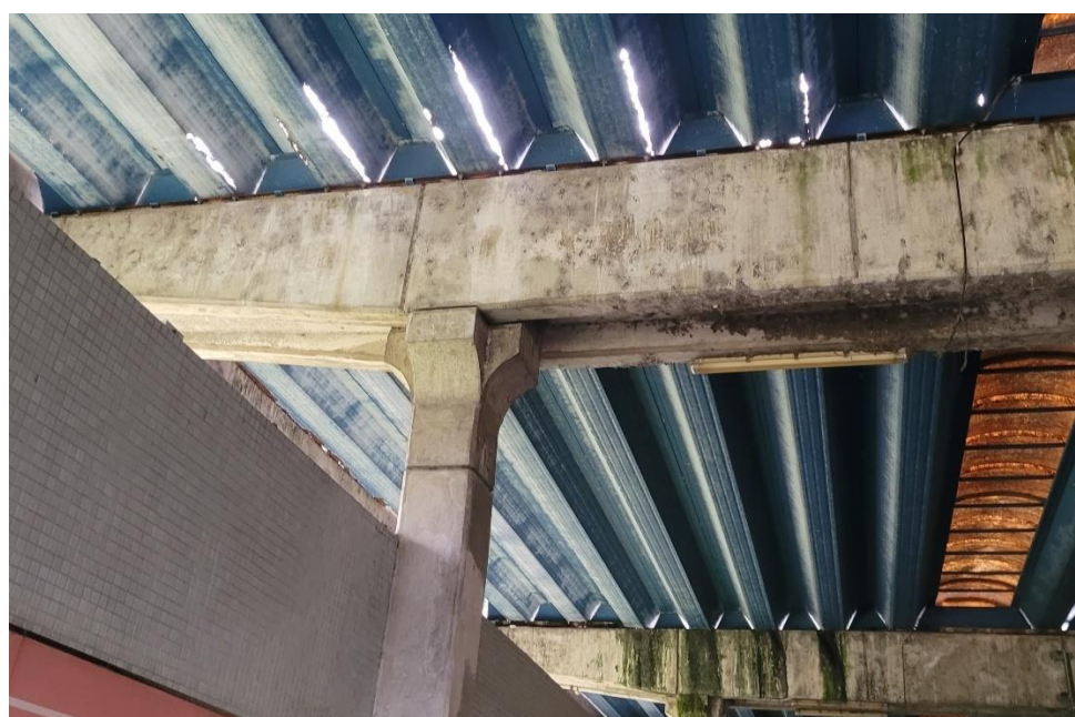
Foto 2-210: Limpeza e tratamento do concreto aparente e Telhas e Domus danificados
