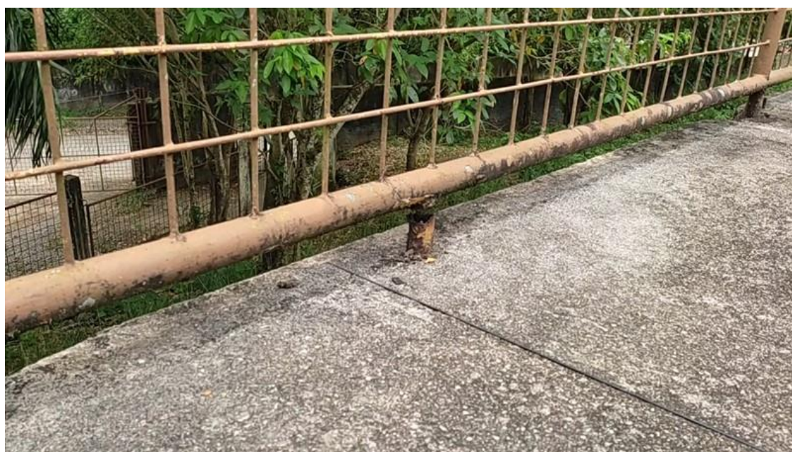
Foto 4-93: Gradis metálicos soltos na base e em avançado estado de corrosão
