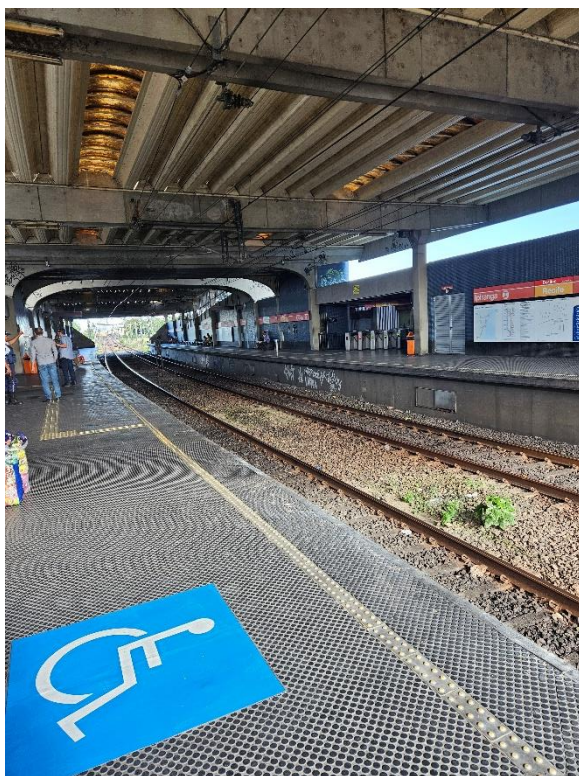
Foto 2-49: Plataforma – Piso tátil e Sinalização de Embarque Preferencial em desacordo as Normas
