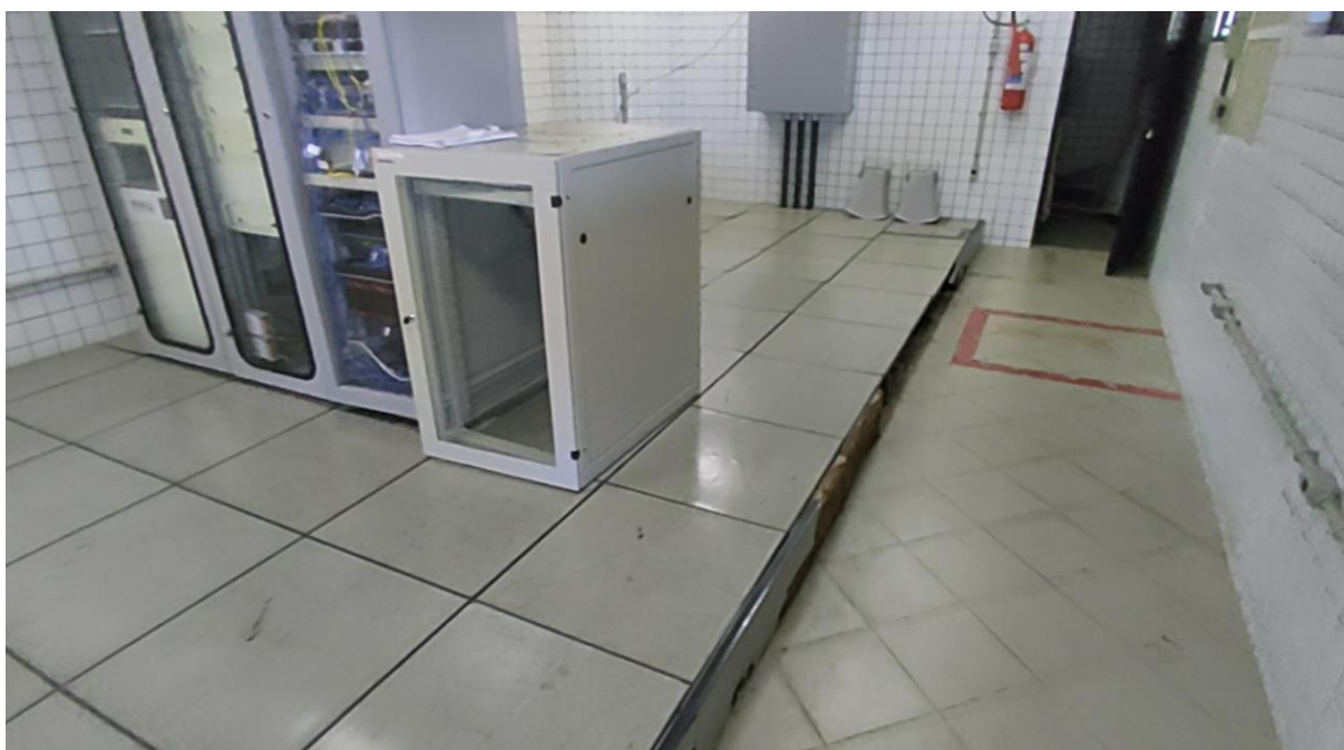
Foto 3-18: Piso falso da Sala Técnica (Telecomunicações) deteriorado por humidade
