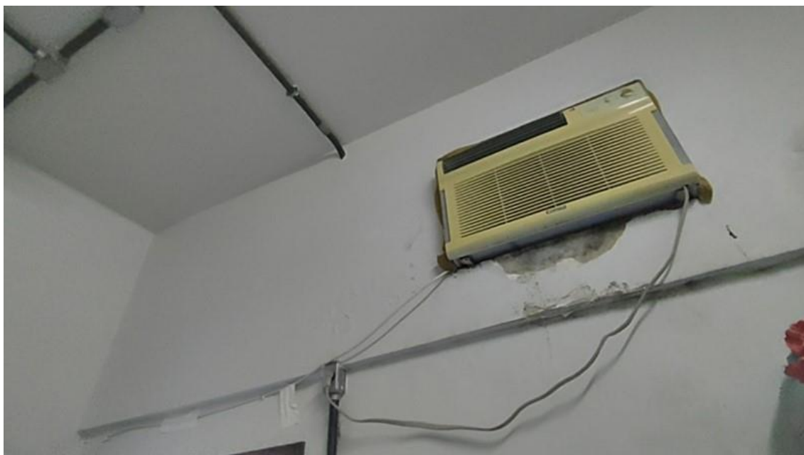
Foto 3-177: Parede comprometida em sala técnica
