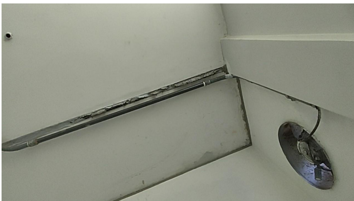
Foto 3-41: Laje apresentando sinais de infiltração
