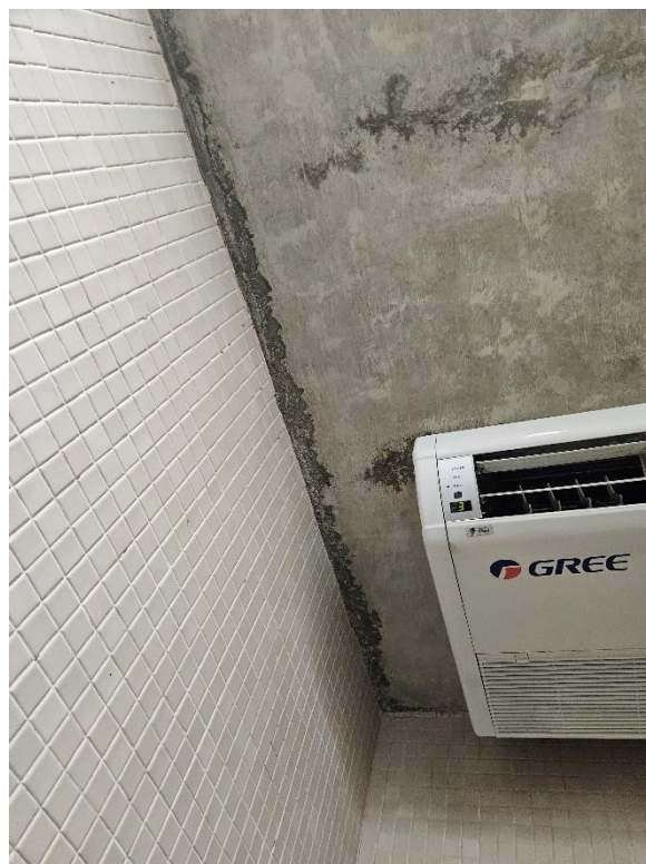
Foto 2-104: Salas Técnicas – Infiltrações
