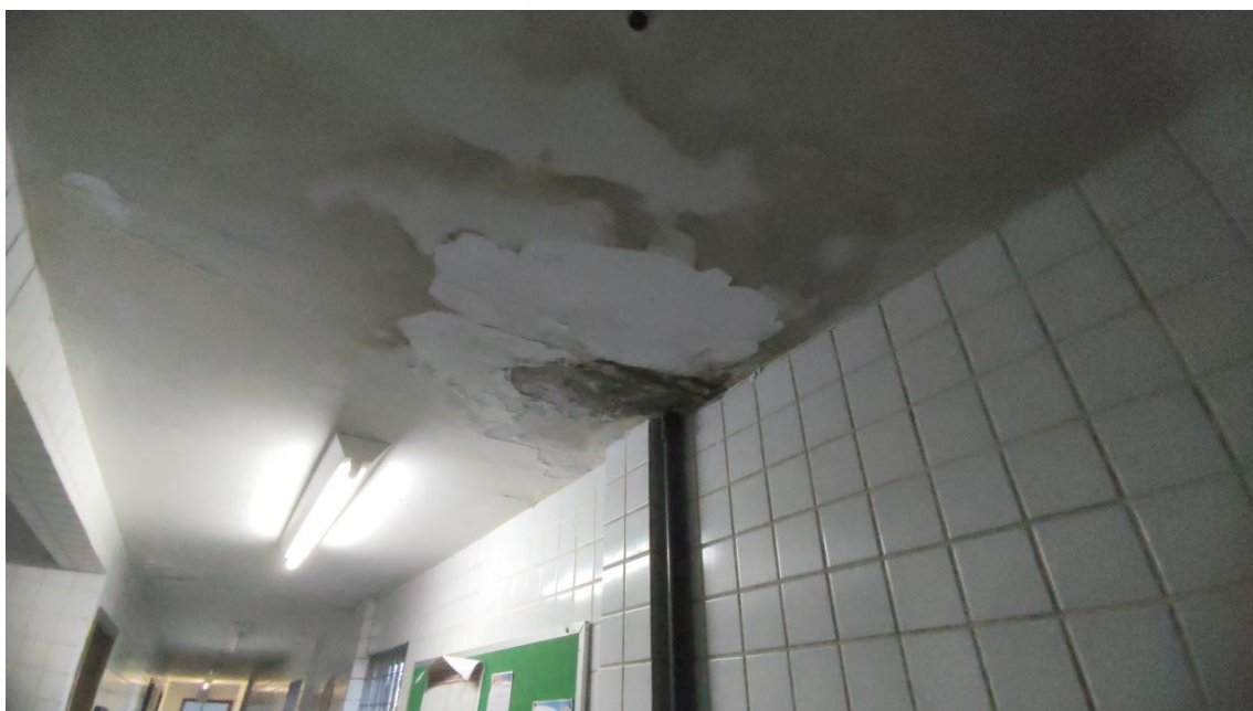
Foto 3-39: Marcas de infiltração na laje de corredor
