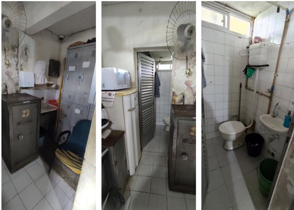
Foto 4-29: Salas operacionais sem acessibilidade, com paredes de pintura descascada. Precisa de renovação geral. Ausência de vestiários
