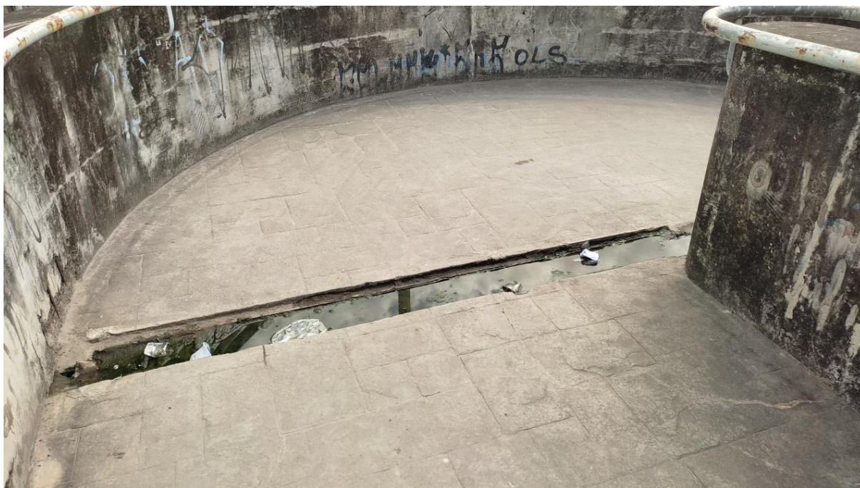
Foto 3-215: Drenagem deficitária na passarela de acesso a estação
