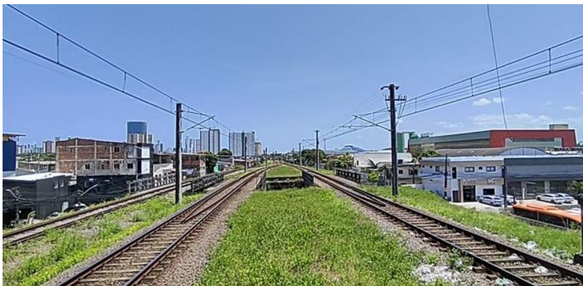
Foto 3-53: Vista geral da via permanente (sentido Recife – Cajueiro Seco). A esquerda se observa a terceira linha, em bitola métrica
