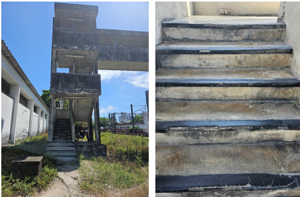
Foto 2-15: Passarela Área Operacional – Infiltrações, Rachaduras, Degraus Danificados, Ausência de Elementos
