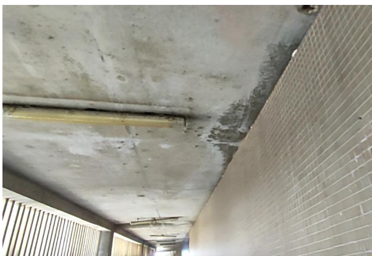
Foto 2-29: Rampa de Acesso a Plataforma - Ferragem exposta e revestimento cerâmico danificado
