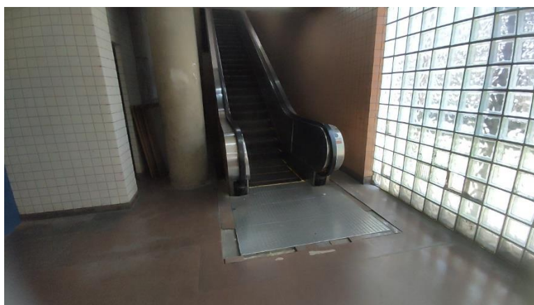
Foto 2-251: Escadas rolantes – Piso danificado, ausência de comunicação visual e alerta
