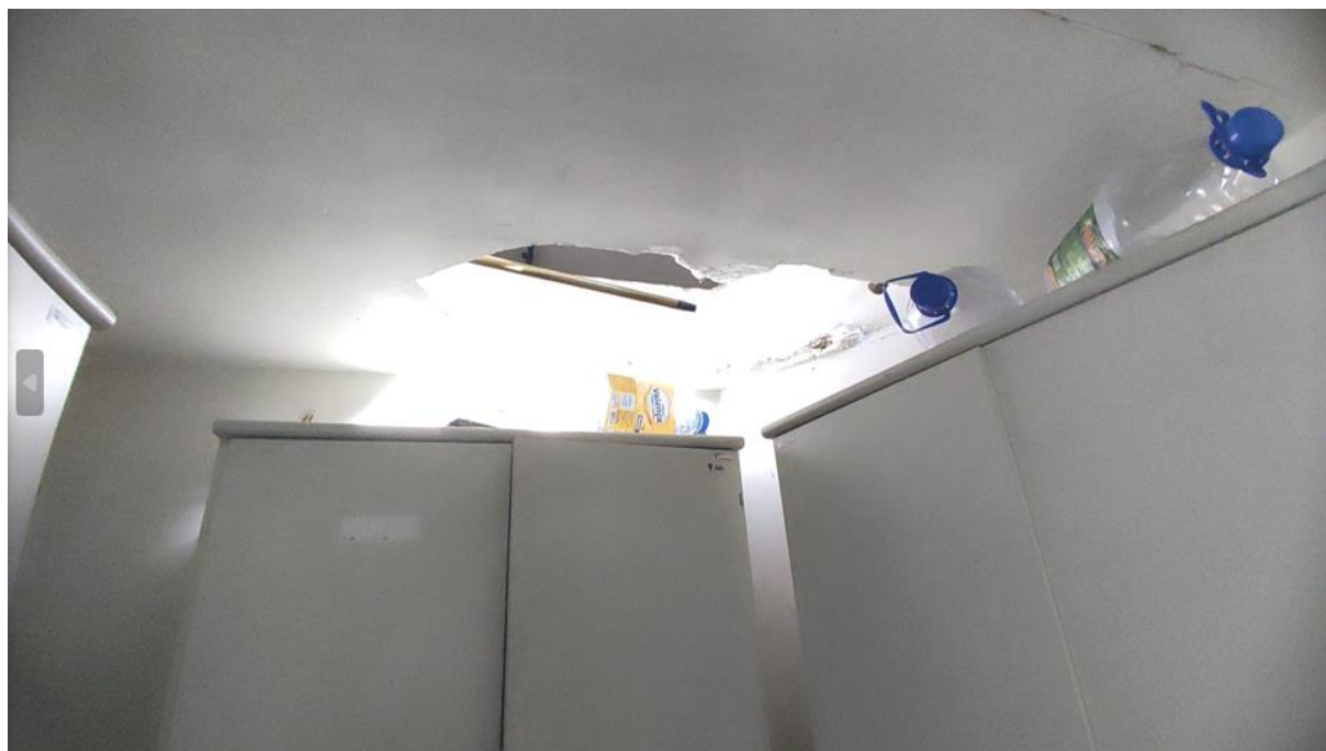
Foto 3-196: Forro danificado em depósito de materiais
