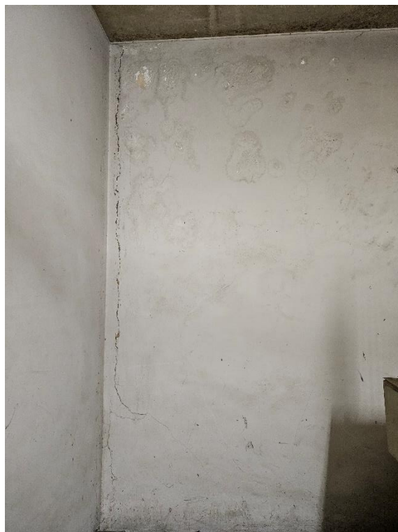
Foto 2-134: Salas Técnicas – Infiltrações e Rachaduras
