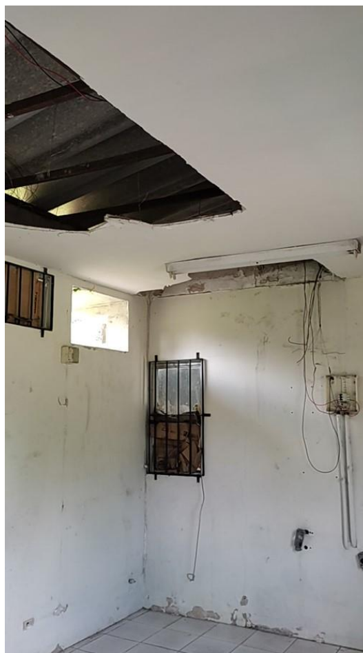
Foto 4-105: Módulo da área operacional interditado; parte sem forro e fiação solta
