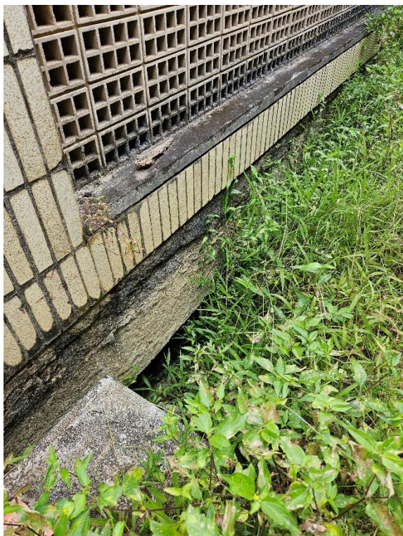
Foto 2-136: Problemas estruturais – perda de solo sob o edifício operacional, murro de arrumo com rachaduras
