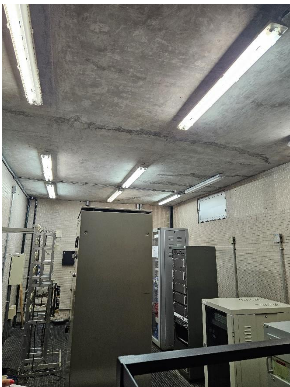
Foto 2-104: Salas Técnicas – Infiltrações
