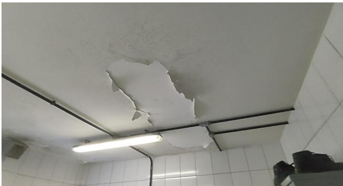
Foto 3-139: Laje de vestiário com pintura descascada e apresentando marcas de infiltração
