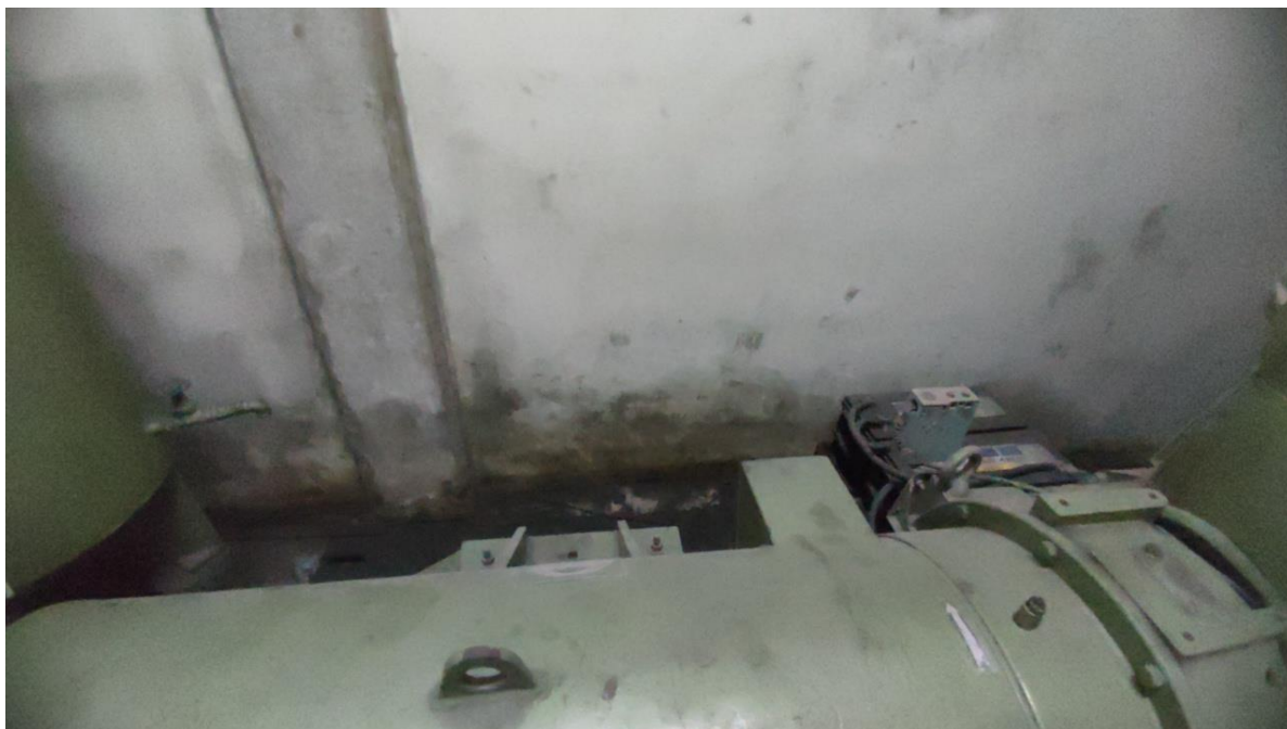
Foto 2-189: Infiltrações em Salas Técnicas
