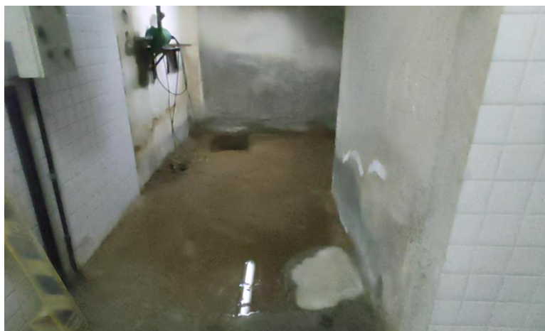
Foto 2-244: Água minando em área sob a escada, a direita temos a Caixa do Elevador
