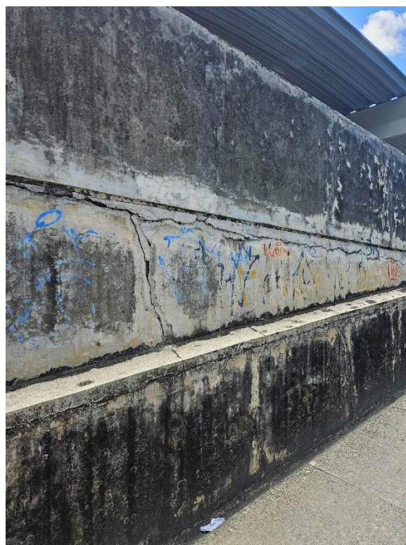
Foto 2-113: Acessos – Trincas e Infiltrações
