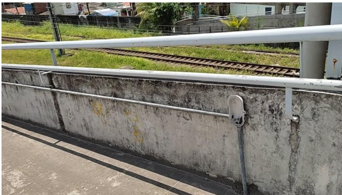
Foto 3-94: Equipamento de iluminação quebrado na passarela da Estação
