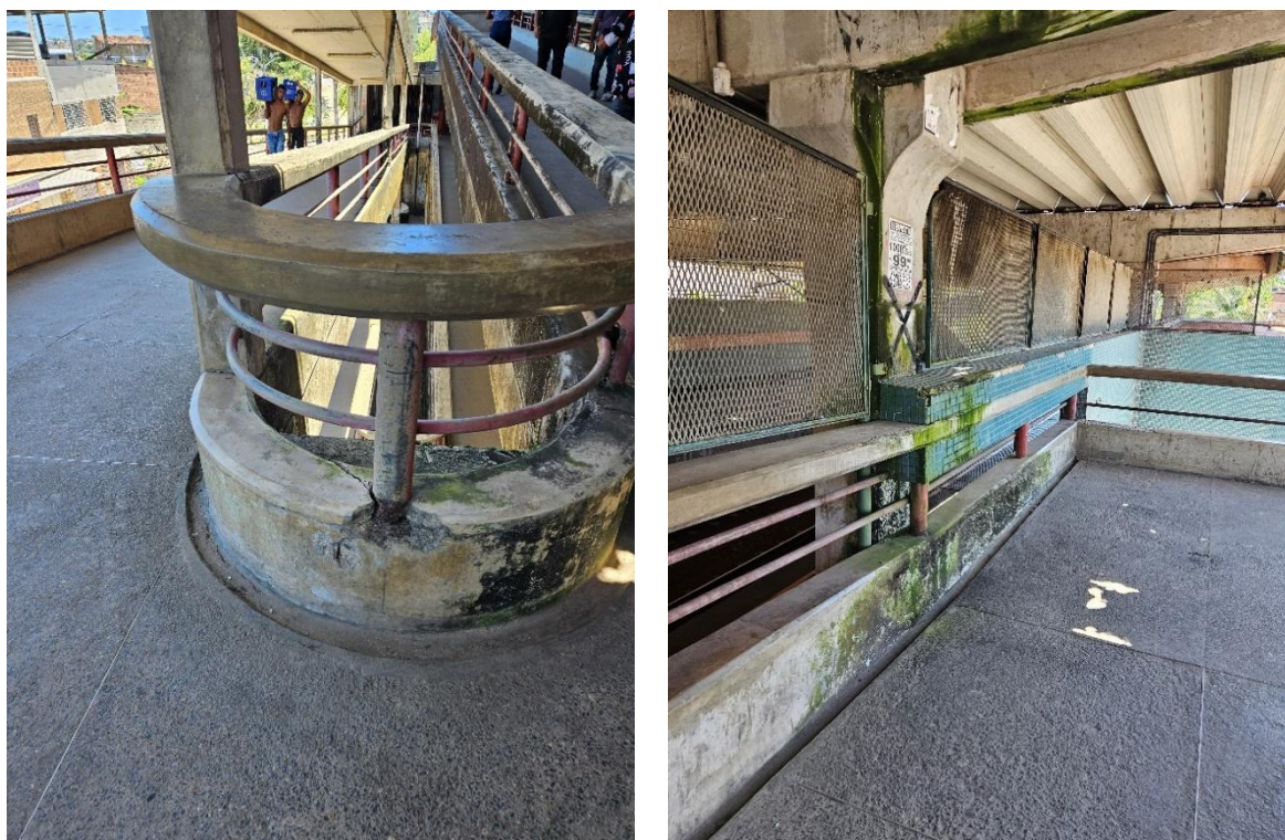
Foto 2-198: Rampas e Passarela – desnível por lance maior que o permitido em norma, ausência de elementos de acessibilidade, infiltrações, lodo e ferragens expostas
