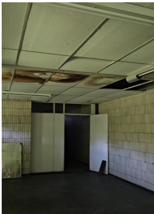
Foto 2-222: Área inoperante, possui infraestrutura elétrica, hidráulica. Revestimentos degradados e infiltrações.
