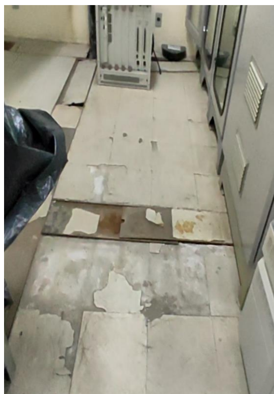
Foto 2-23: Salas Técnicas – Equipamentos cobertos devido a infiltrações, pisos danificados
