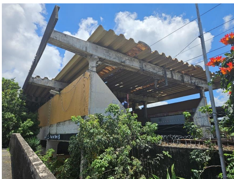
Foto 2-111: Cobertura – Faltam algumas Telhas, Telhas e domus danificados
