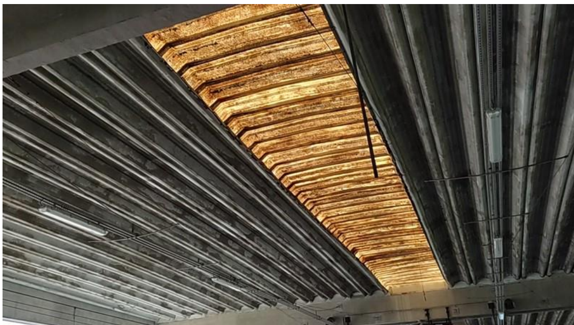
Foto 3-133: Domus e telhas da cobertura degradadas; permitindo infiltração de água na região da escada fixa
